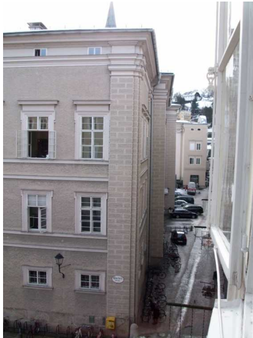
Abbildung 43: Blick auf den Trakt in die Sigmund Haffner Gasse in Richtung Süden, 2010
