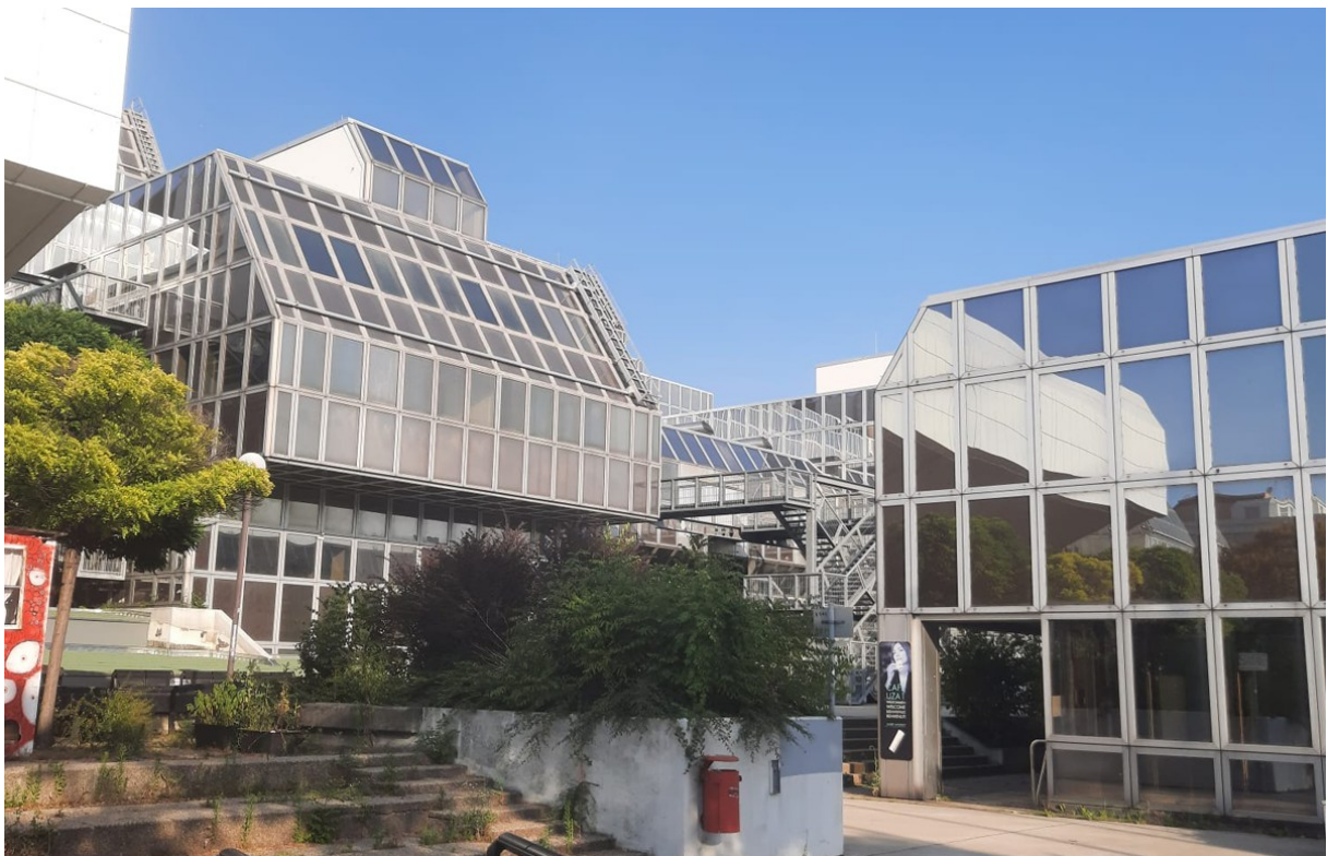
Abbildung 10: Außenansicht des Haupteingangs und des Mensagebäudes der ehemaligen Wirtschaftsuniversität (© Lucy Hofmann, KRW, 2022)
