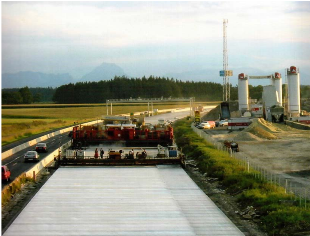
Abb. 45: Autobahnbau mit mobilem Betonwerk (re) bei Wels/OÖ.
