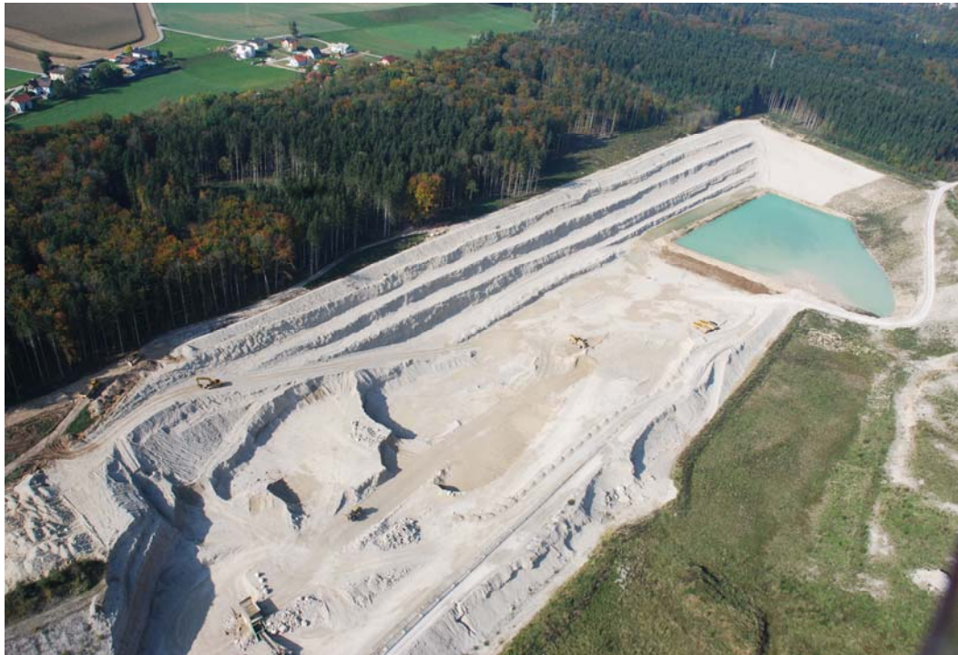
Abb. 31: Abbaustandort Hildprechting (Etagenabbau)
