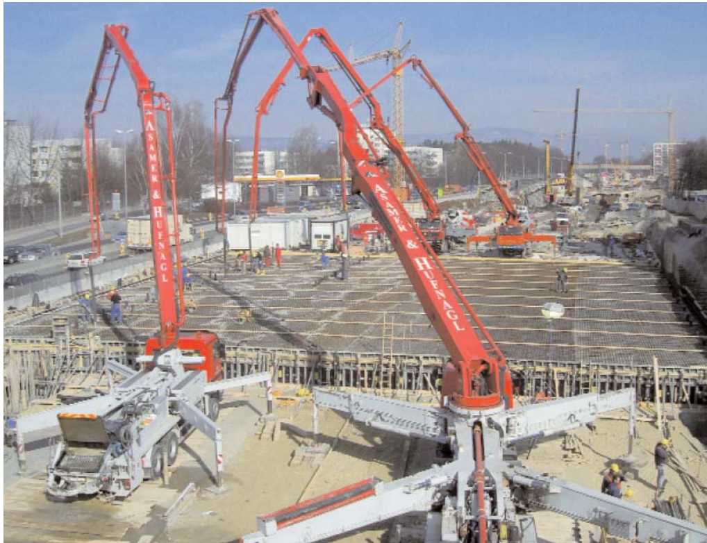
Abb. 46: Baustelle mit Betonpumpen im Einsatz
