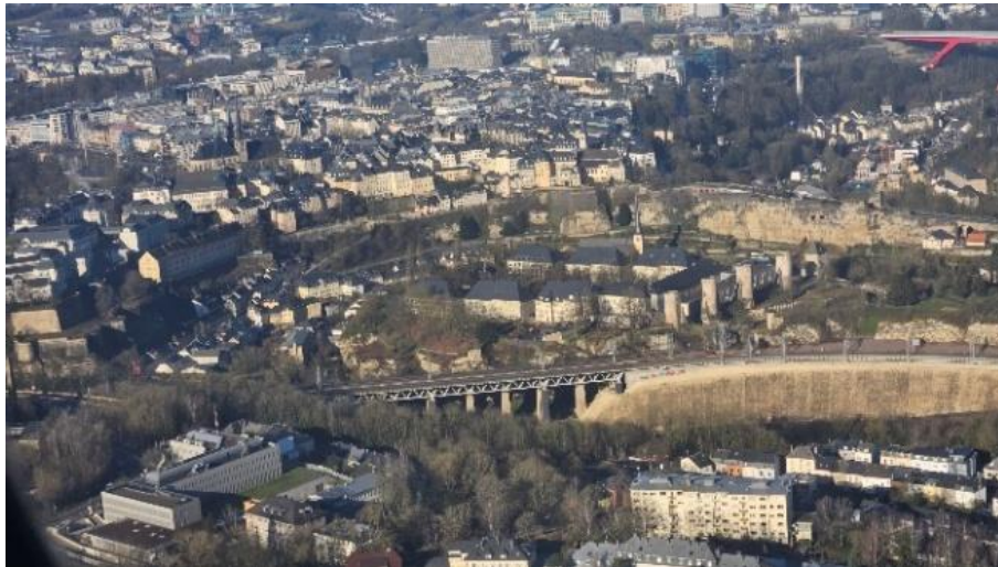
Abb. 2: Luftaufnahme der Corniche-Landschaft mit Oberstadt, ©M. Voncken 02.2025.
