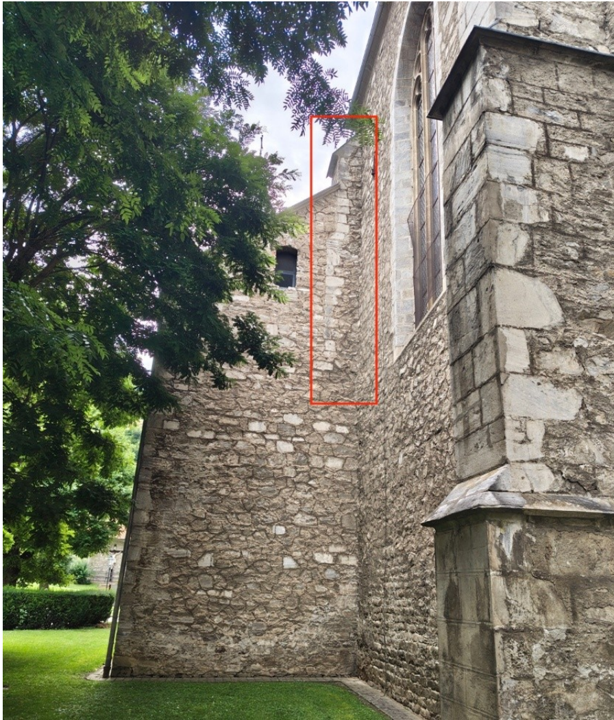
Abb. 144: Reste eines stützenden Strebepfeilers im Mauerverband, Ostwand des südlichen Seitenschiffes, Fotografie, eigene Bearbeitung, 2025.
