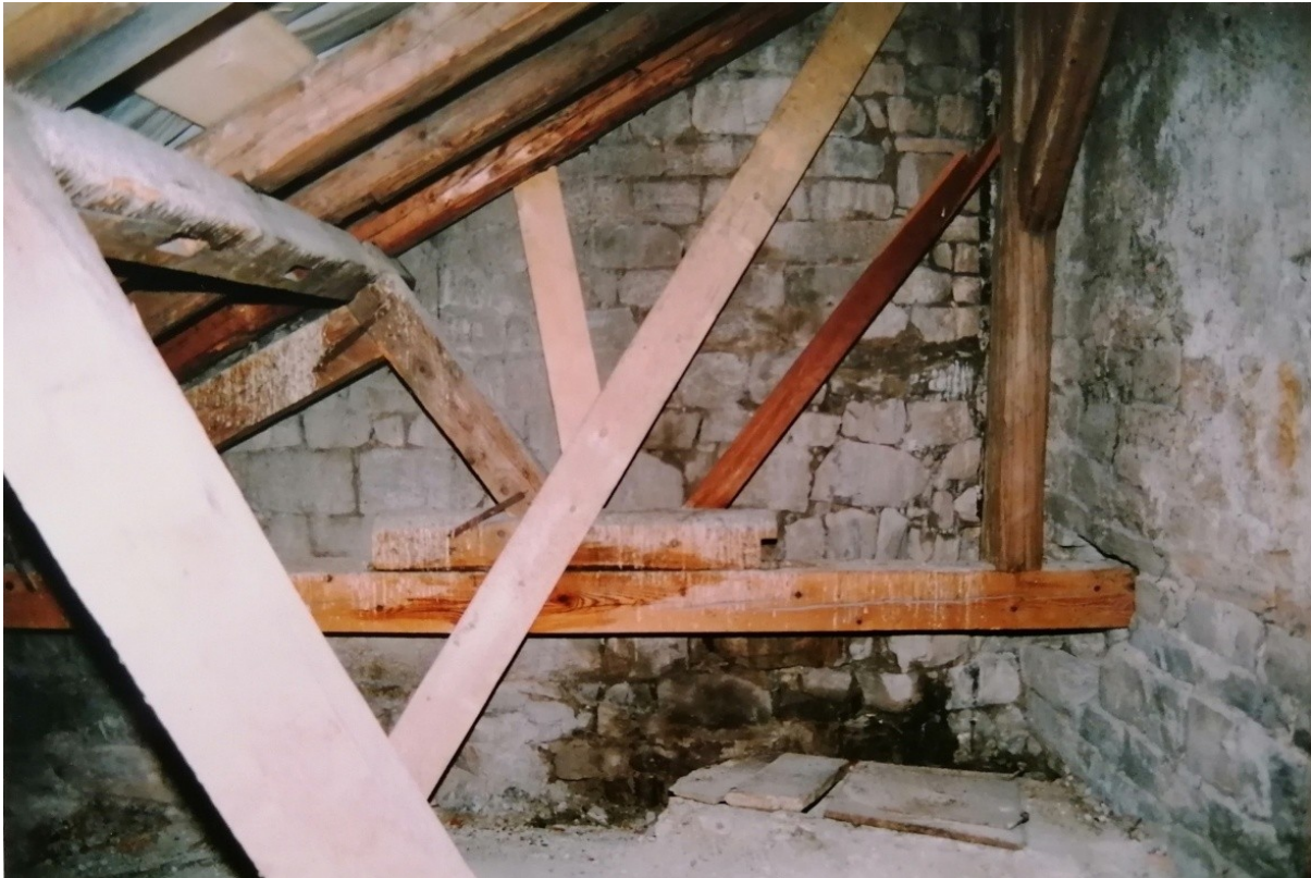
Abb. 79: „Dachraum über dem südlichen Seitenschiff“, 1. Joch von Westen, Fotografie, 2002.
