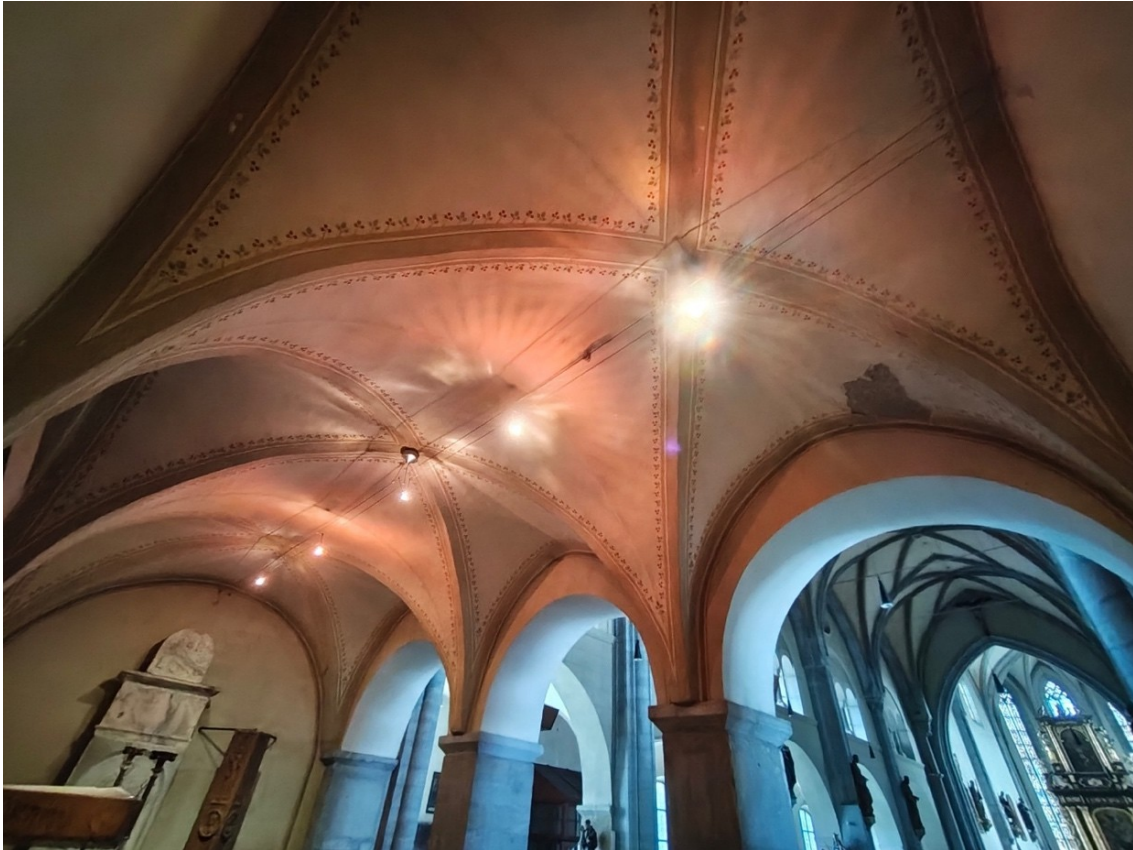
Abb. 95: Gewölbe im Narthex, St. Bartholomäuskirche, Friesach, Fotografie, 2025.
