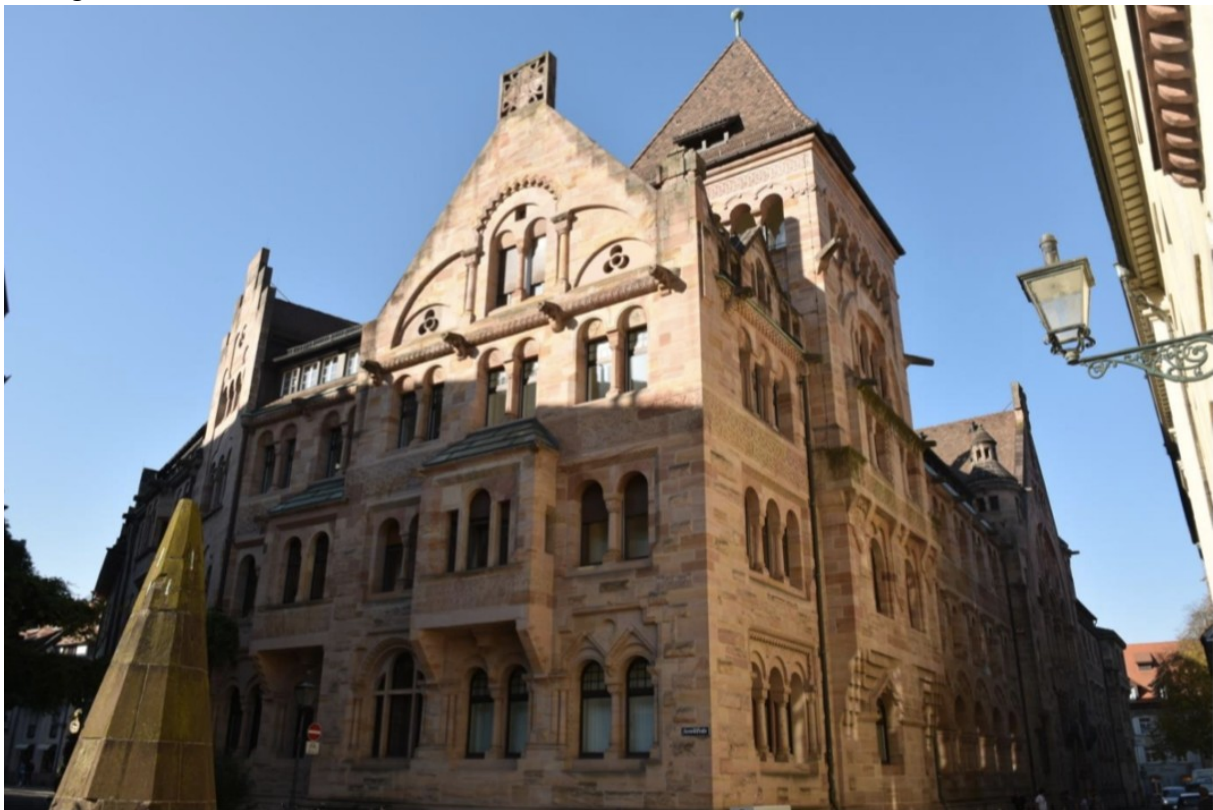
Abb. 9: Ost- und Südfassade, Erzbischöfliches Ordinariatsgebäude Freiburg, Fotografie.
