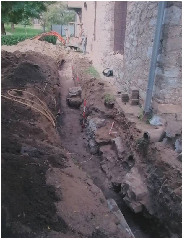
Abb. 140: Grabungen an der Südseite der Kirche, Blick gegen Westen, Fotografie, 11.07.2005.
