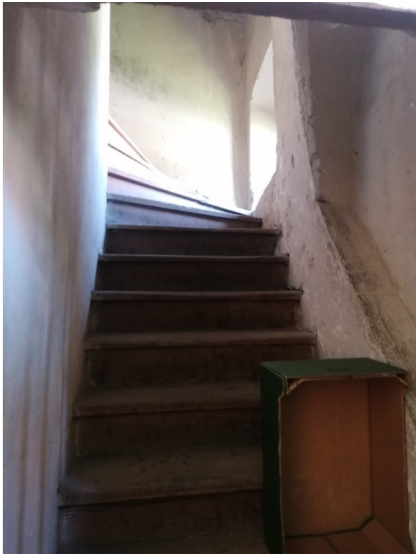
Abb. 114: Wendeltreppe Sakristei, St. Bartholomäuskirche, Friesach, Fotografie, 2024.
