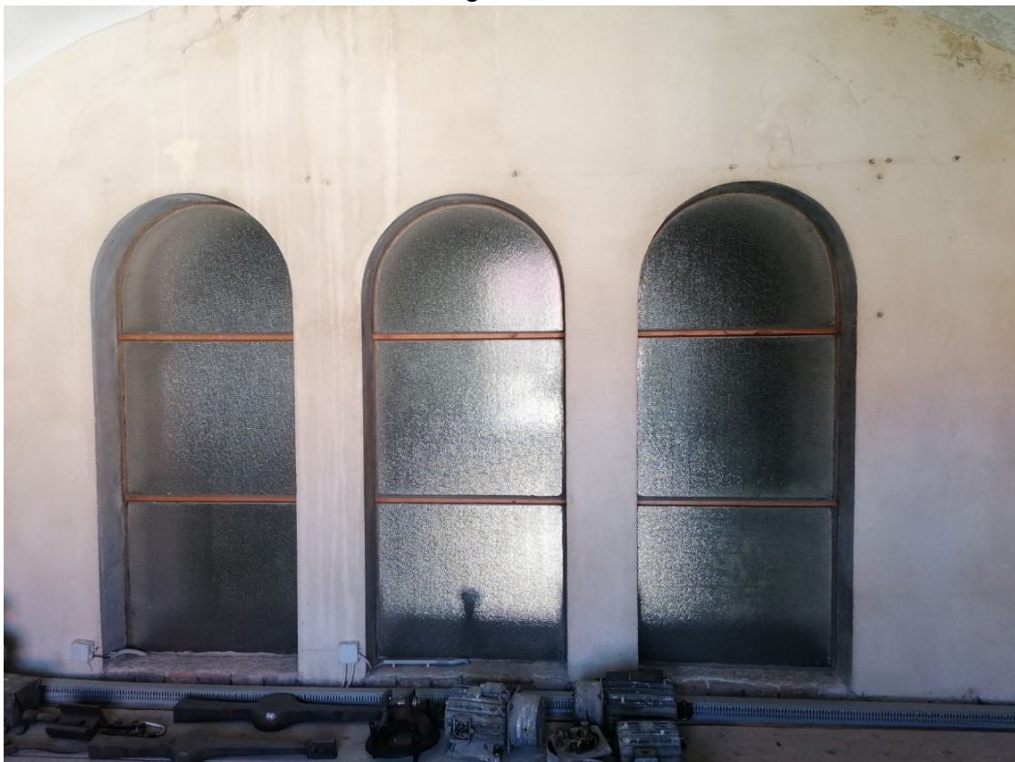
Abb. 100: Triforien in dem Gang über dem nördlichen Seitenschiff, St. Bartholomäuskirche, Friesach, Fotografie, 2024.
