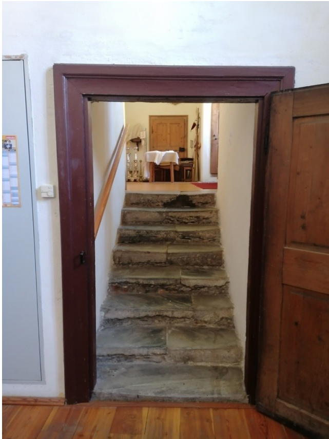
Abb. 113: Verbindungstreppe zwischen den Sakristeiräumen, St. Bartholomäuskirche, Friesach, Fotografie, 2024.
