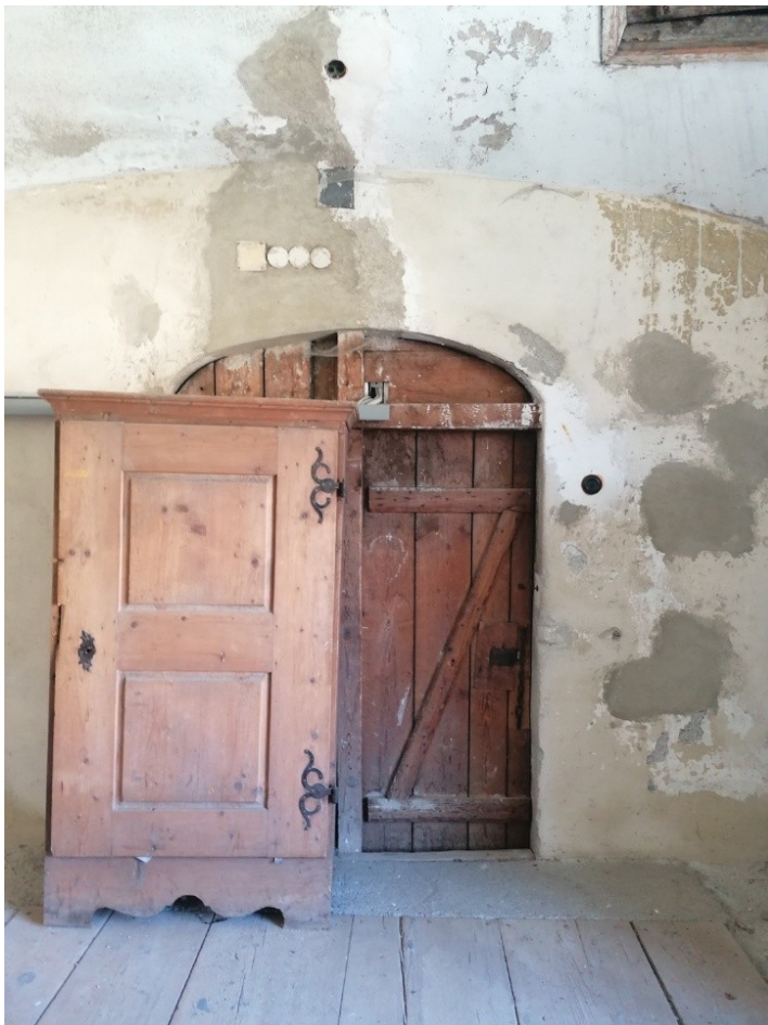
Abb. 118: Türe zum Nordturm, 1. OG nördliches Seitenschiff, St. Bartholomäuskirche, Friesach, Fotografie, 2024.
