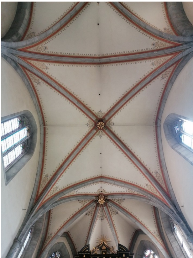
Abb. 108: Gewölbe 2. Chorvorjoch und Chor, St. Bartholomäuskirche, Friesach, Fotografie, 2024.
