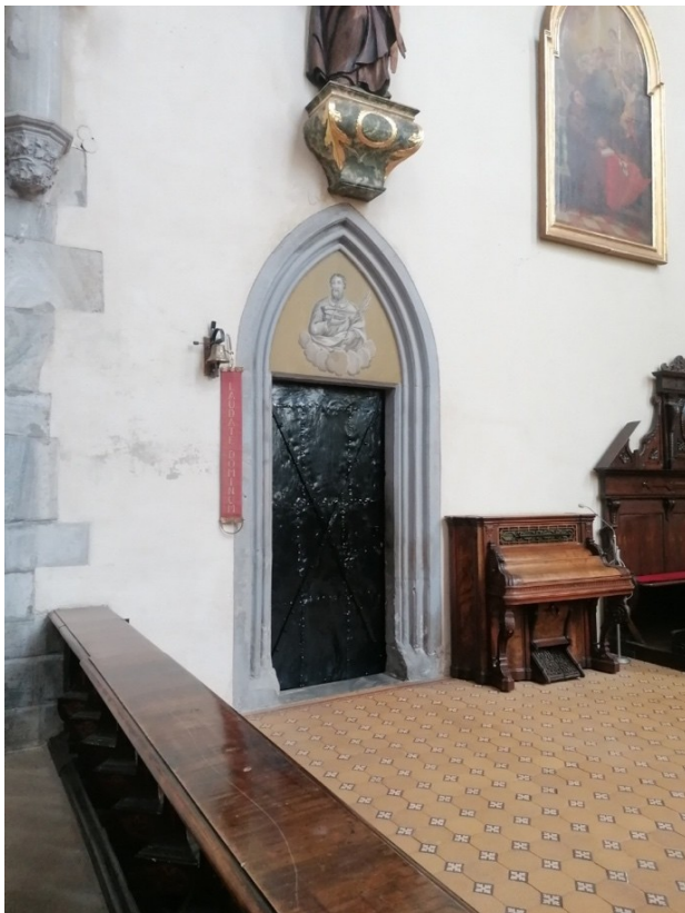
Abb. 112: Eingang zur Sakristei, St. Bartholomäuskirche, Friesach, Fotografie, 2024.
