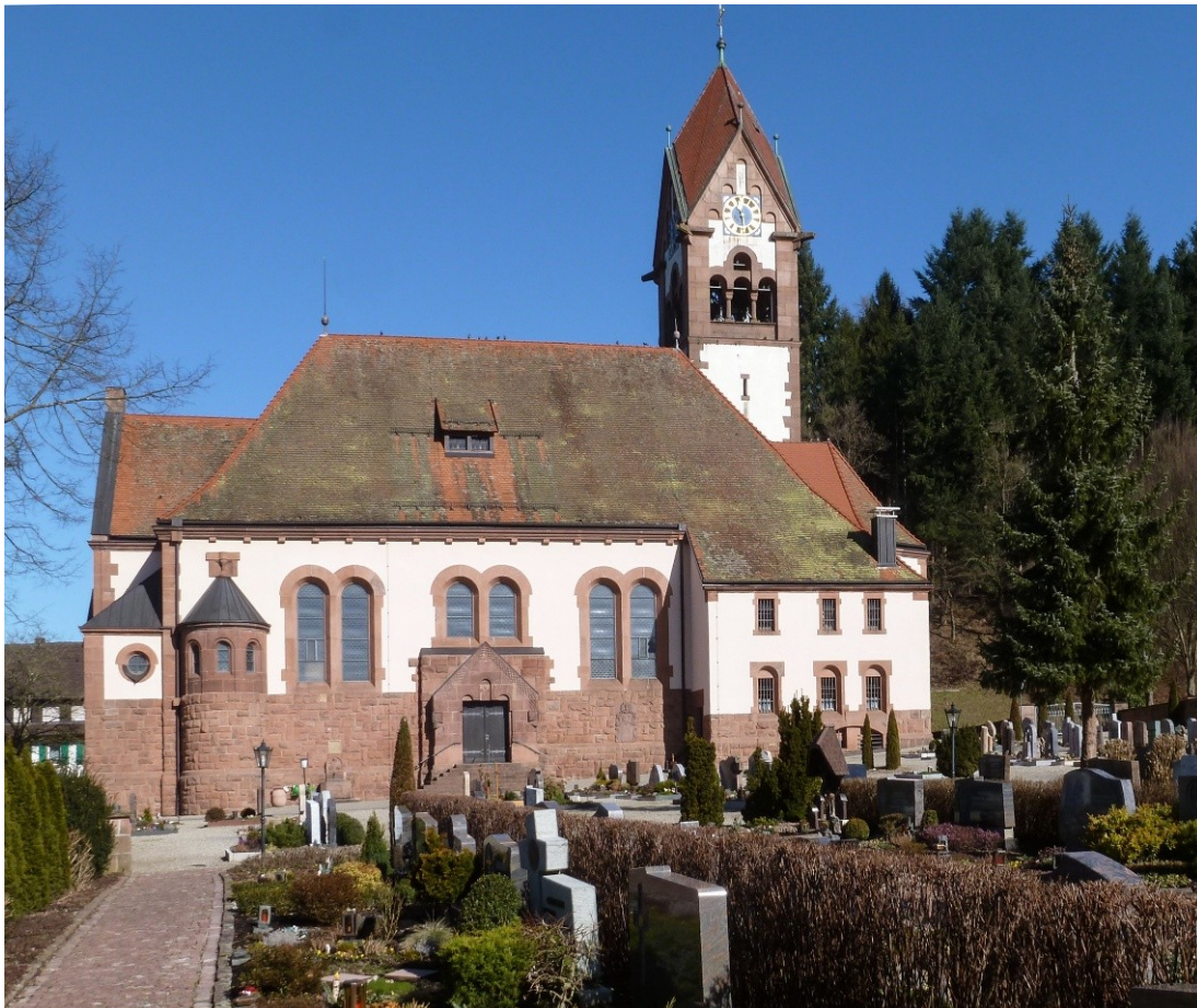
Abb. 16: Außenansicht, St. Antonius, Schuttertal bei Lahr, Fotografie.
