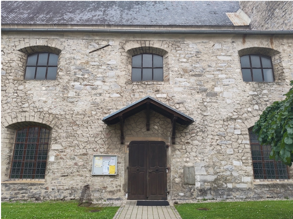
Abb. 88: Nördliches Seitenschiff, Fensteraufteilung, St. Bartholomäuskirche, Friesach, Fotografie, 2024.
