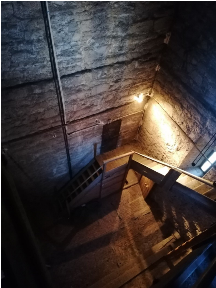
Abb. 120: Treppenhaus Nordturm, St. Bartholomäuskirche, Friesach, Fotografie, 2024.
