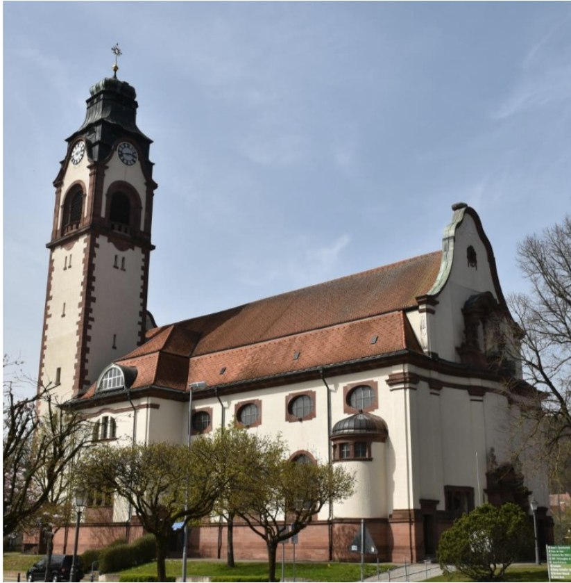
Abb. 19: Außenansicht, Pfarrkirche St. Josef, Kollnau, Fotografie.
