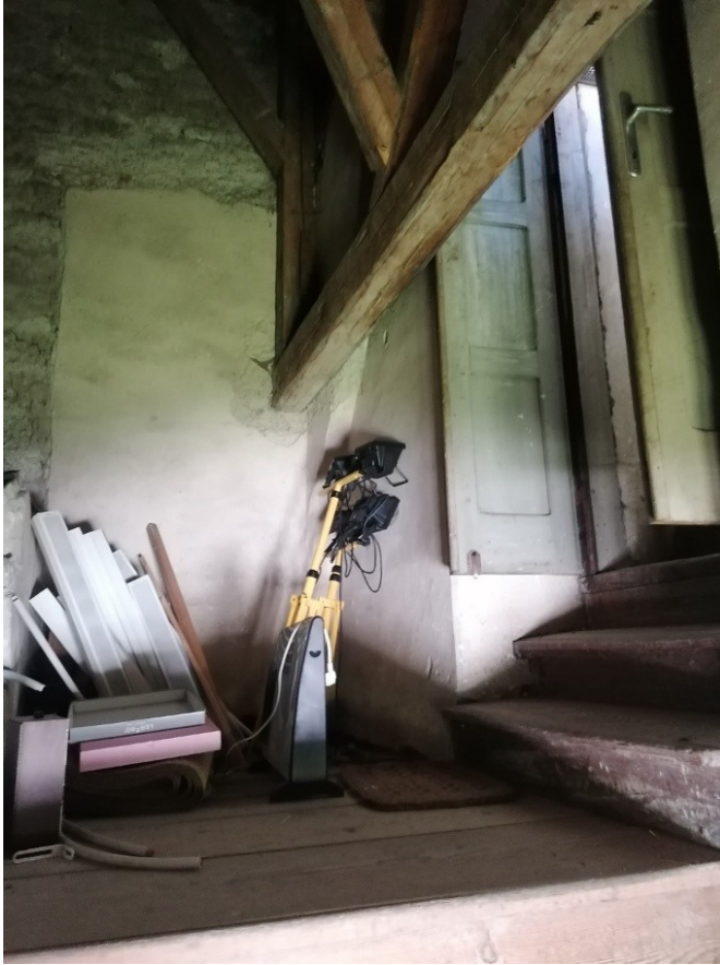
Abb. 115: Vorraum Obergeschoss nördliches Seitenschiff, St. Bartholomäuskirche, Friesach, Fotografie, 2024.
