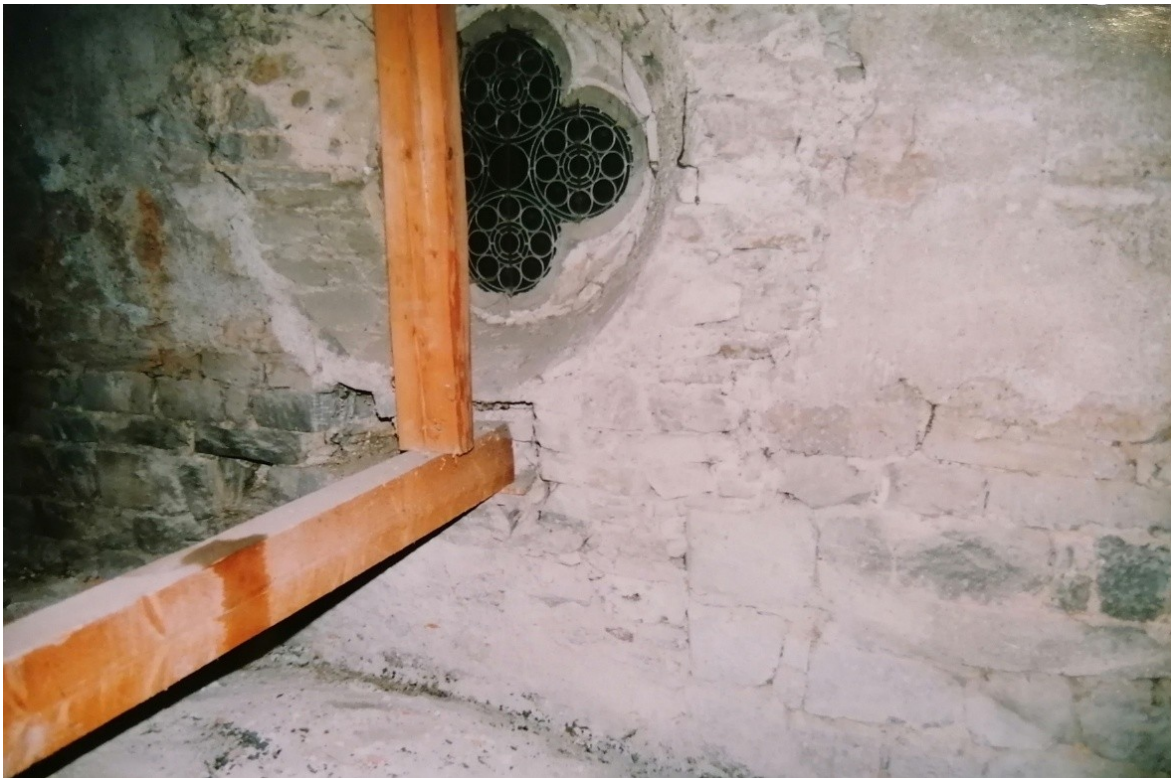
Abb. 80: „Dachraum über dem südlichen Seitenschiff“, 1. Joch von Westen, Fotografie, 2002.
