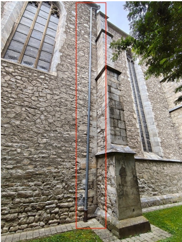
Abb. 141: Baunaht an der Südseite der Kirche beim Presbyterium, Fotografie, eigene Bearbeitung, 2025.
