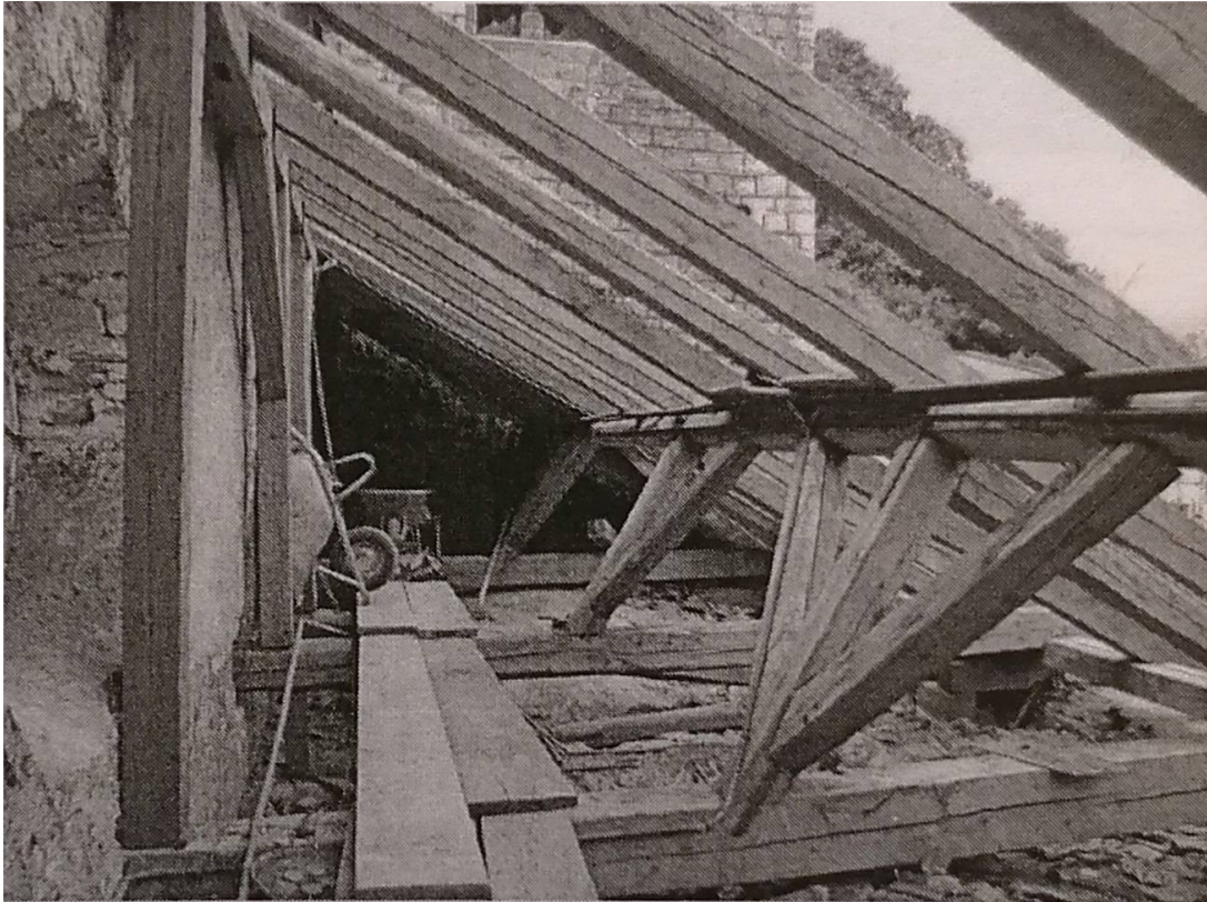
Abb. 138: Sanierungsarbeiten Dachstuhl nördliches Seitenschiff, Fotografie, 2006.
