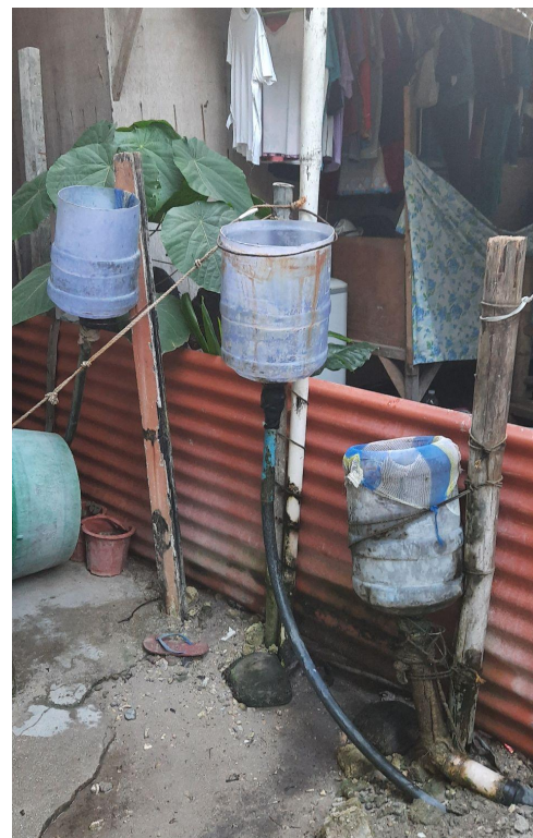
Abb. 13: Improvisierte manuell betriebene Wasserleitungssysteme auf Malapascua
