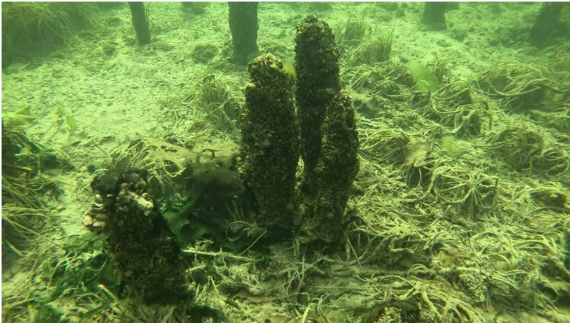
Abb. 4.11.: Foto: Mondsee, Station See, Pfähle mit Quagga-Muschelbefall.
