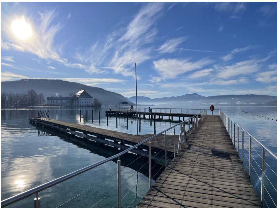
Abb. A.13.: Foto: Attersee, Seewalchen I, Panoramasteganlage
