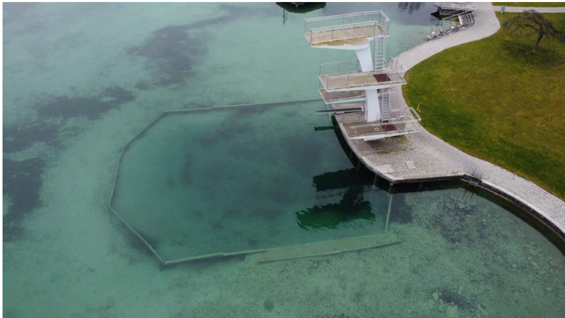
Abb. A.11.: Foto: Attersee, Seewalchen I, Drohnenaufnahme des Bereichs der Sprungturmgrube, © Immo Trinks
