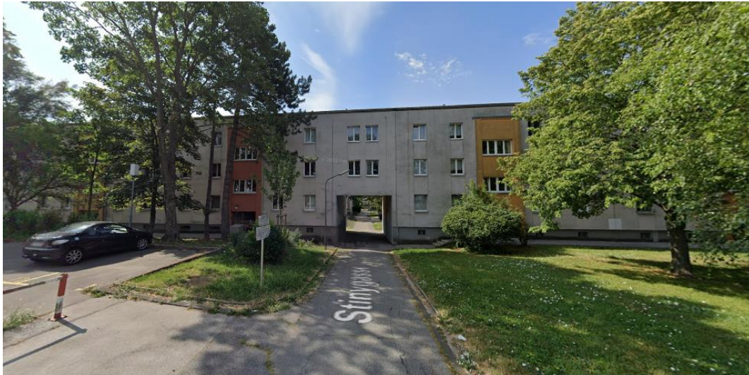
Abb. 19: Per-Albin-Hansson-Siedlung Nord, Blick von Norden auf die Stinygasse 188
