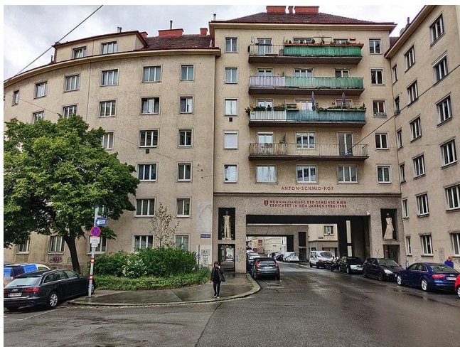
Abb. 17: Beispiel für eine Überbrückung bei einem Gemeindebau der Nachkriegszeit ( Anton-Schmid-Hof ). 179
