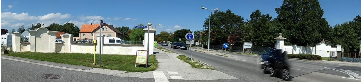
Abb. 42: Theresienfeld Zugang zur Siedlung von Süden. Konvex und konkav geschwungene Mauer am Ortseingang, bemerkenswert ist die erhebliche Breite der Straße und die somit vorliegende Distanz der Häuser zueinander, was den Planungscharakter der Siedlung gegenüber einer ruralen, historisch gewachsenen Siedlung verdeutlicht.
