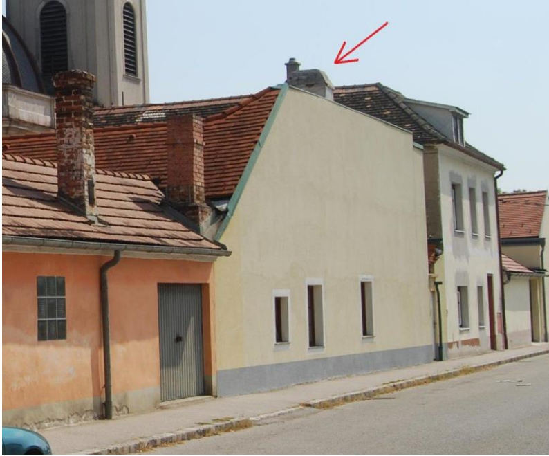
Abb. 40: Arbeiterhaus Fabriksgasse 18, fotografiert Richtung Osten von Adlertorgasse. Oben ist der ehemalige Kamin des 19. Jh. vor Abriss zu sehen. Dies war das letzte Haus der Fabriksgasse mit historischem Kamin, der zwischen Oktober 2010 und Januar 2011 erneuert wurde.
