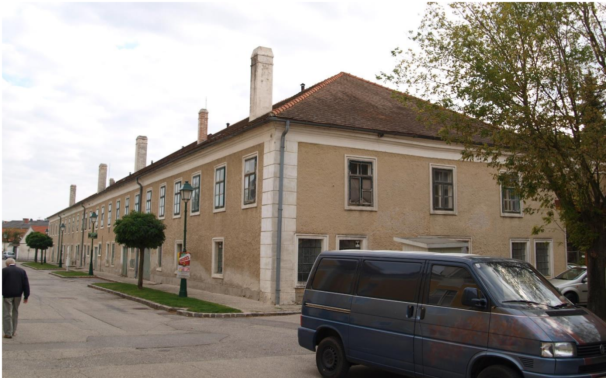
Abb. 36: Langer Gang, Richtung Osten fotografiert, Nord- und Westfassade.
