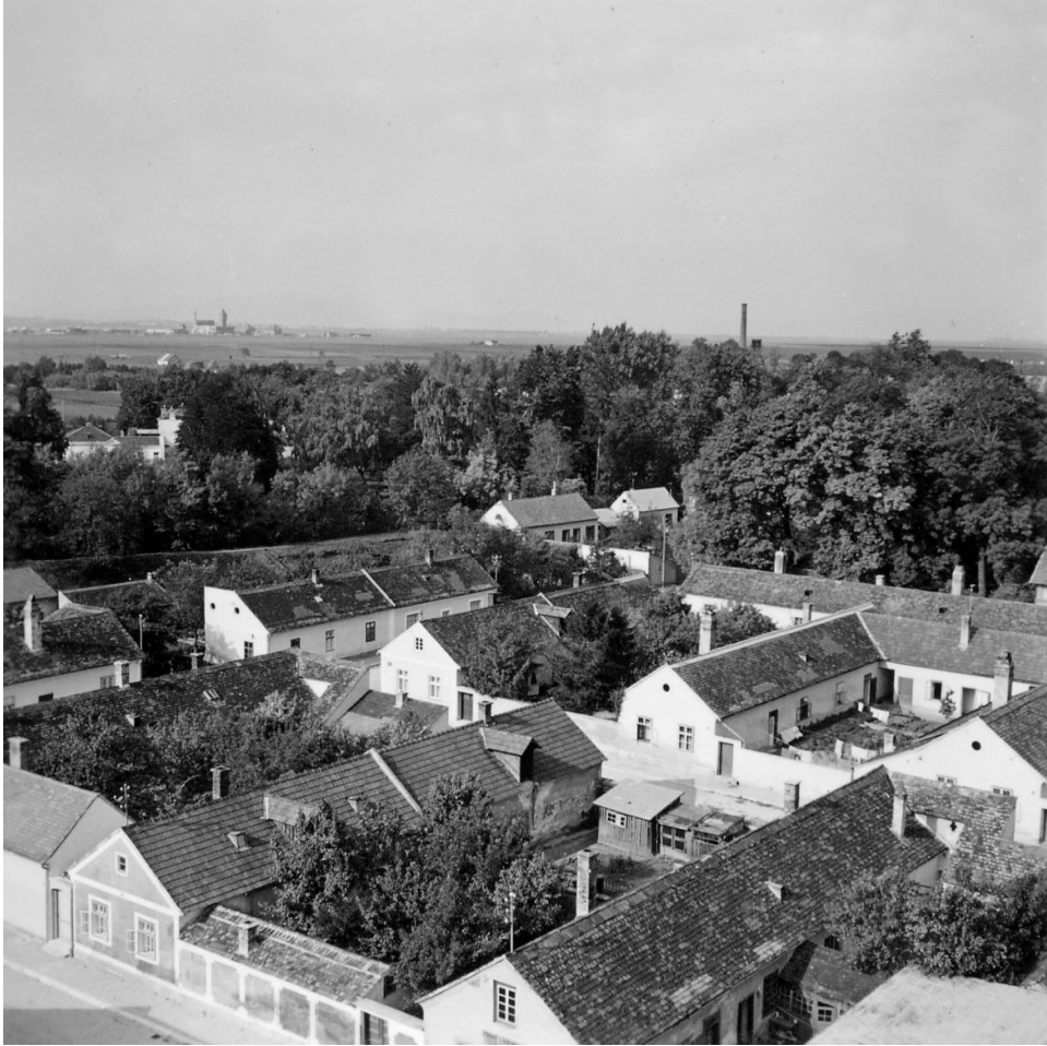
Abb. 23: Fotografie vom Dach der Theresienkirche, um 1955.
