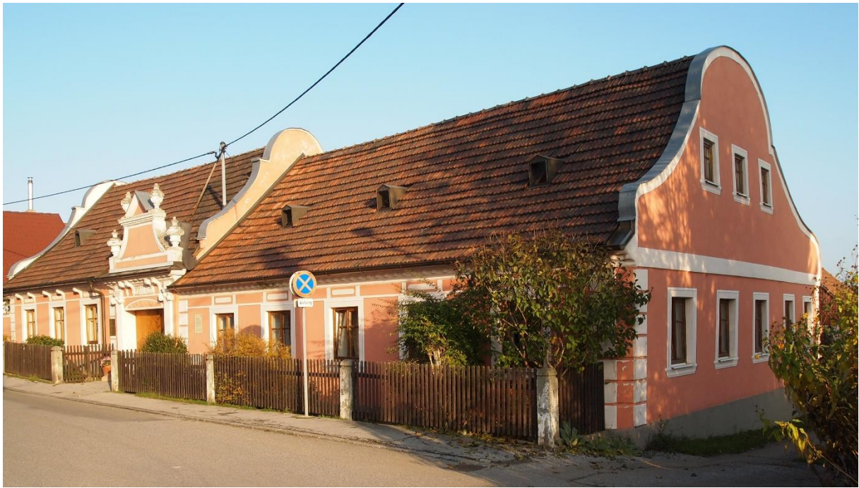
Abb. 46: Bandelweberhaus Groß-Siegharts, Lange Gasse 2.
