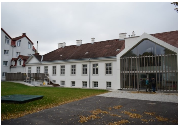
Abb. 15: ehem. Frauenspitalstrakt (sog. Augustinum), Hoffassade, heute Kindergarten, Breitenfurt.
