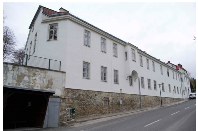
Abb. 16: ehem. Frauenspitalstrakt (sog. Augustinum), Straßenfassade, heute Kindergarten, Breitenfurt.
