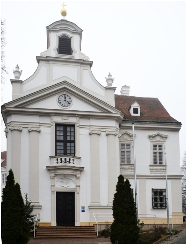
Abb. 13: Kirche St. Johann, Seitenfassade, ehem. Gartenfassade des Schlosses Breitenfurt mit Originalschmuck.
