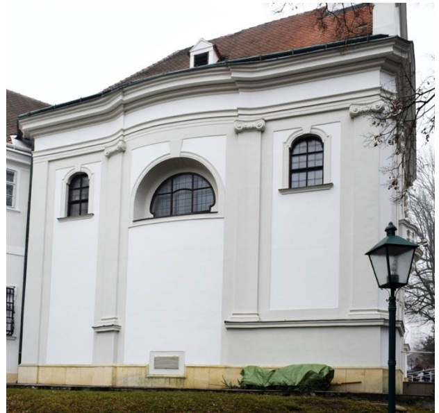
Abb. 14: Kirche St. Johann, Seitenfassade, ehem. Gartenfassade des Schlosses Breitenfurt mit Originalschmuck.
