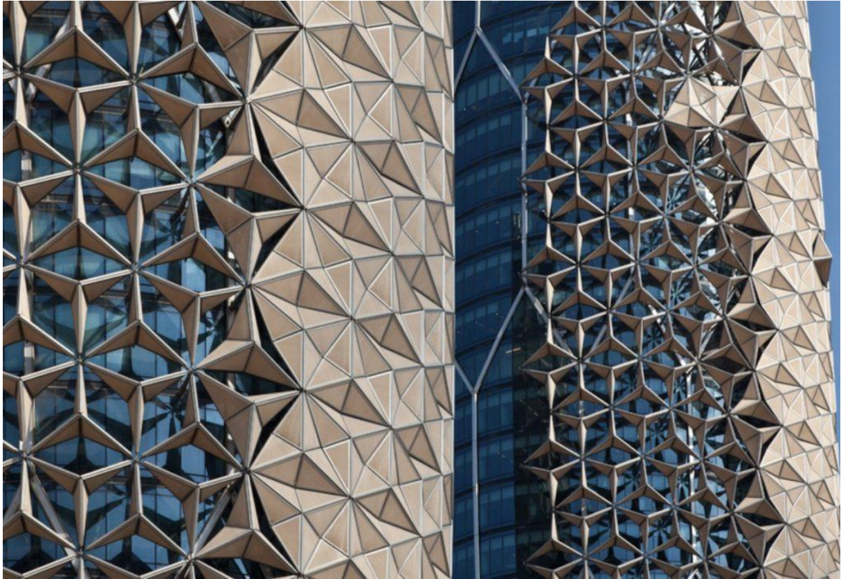
Abbildung 21: Al Bahar Tower in Abu Dhabi, Quelle: Kaur 2019.
