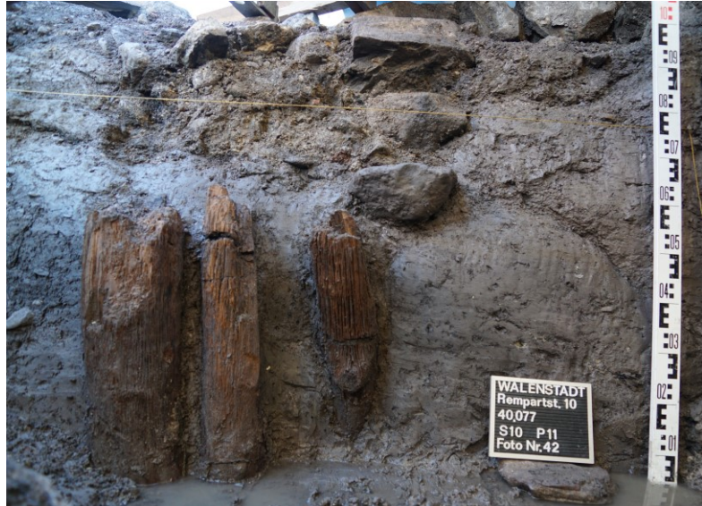
Abbildung 33: Walenstadt, Rempartstrasse 10: Profil 14 (Fototafel falsch), Erlenpfähle unter Mauer 11. Zwischen den Pfählen und dem Mauerwerk liegt der eingeschwennte Planierungslehm PH2.1_PS1. Blick nach W.
