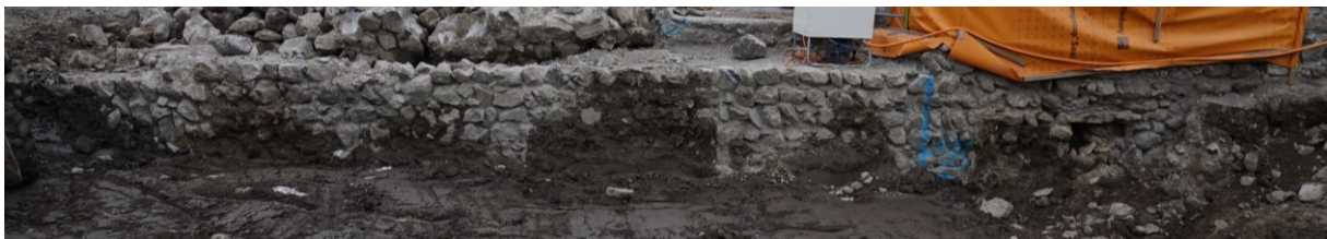
Abbildung 20: Walenstadt, Rempartstrasse 10: Stadtmauer. Die dunklen Flecken zeigen die Stellen, wo die Mauern des Hauses B anstiessen. In der Bildmitte z.B. Mauer 3. Blick nach W.
