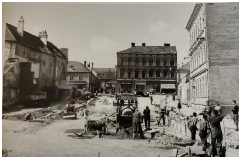
Abbildung 9 Bauarbeiten an der Badstraßenverbreiterung
