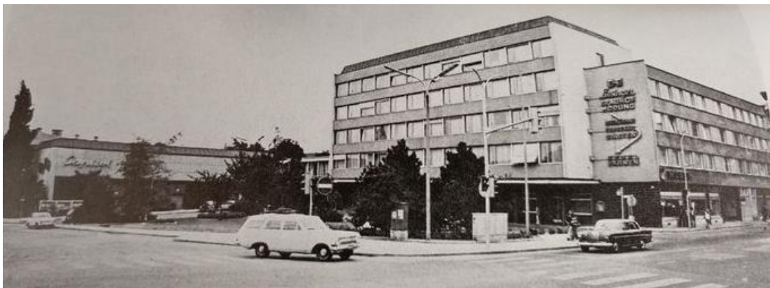
Abbildung 8 Errichtung eines neuen Zentrums (vorher: „Liesinger Brauhof“)
