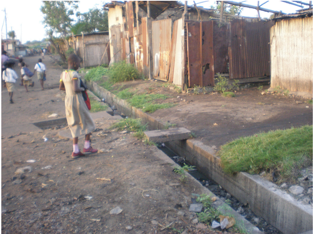
Caniveau sans dalles rempli d'ordures et d'eaux usées domestiques . (Rue du quartier Hanoukopé)
