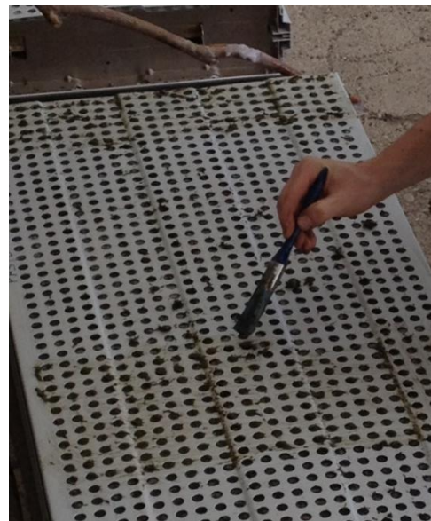
Abb. 44: Auftragen der Mischung
