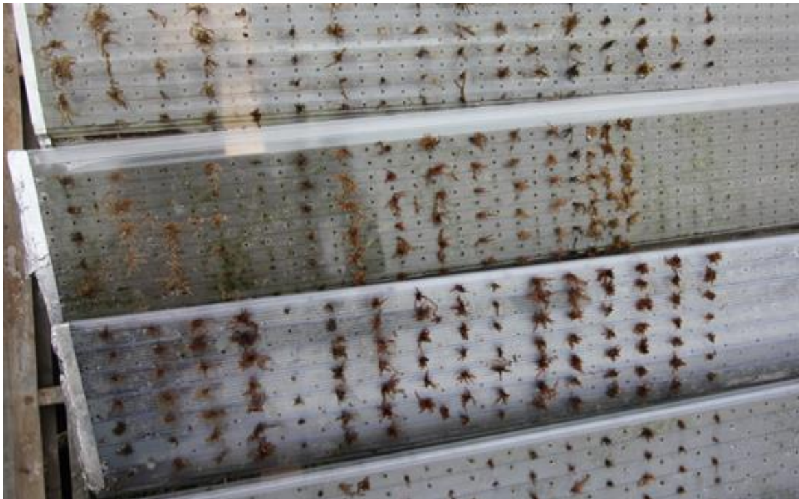
Abb. 54: Abgestorbene Sprosse der Kunststoff-Doppelsteg-Platten (E.H.)
