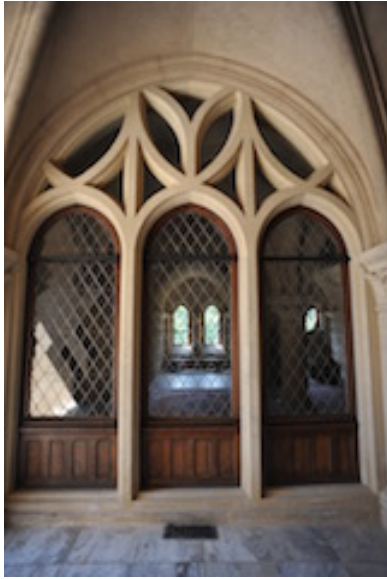
Abb. 49: Bojnice, Masswerkwand, Säulenhalle, 1897-1909.
