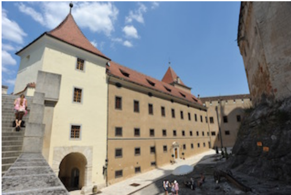
Abb. 87: F. Luchese: Bojnice, 1. Schlosshof, links Eingangsturm, rechts Rentmeister – Trakt, heutiger Zustand.
