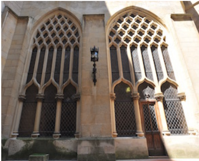
Abb. 31: Bojnica, Viertes Schlosshof, Vorhalle - Reittreppenturm, 1890-1895.
