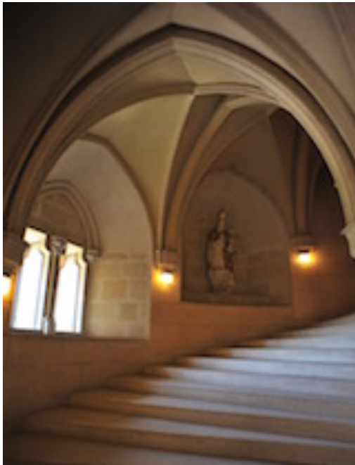
Abb. 26: Bojnice, Reittreppenturm Innen, 1892-1897.
