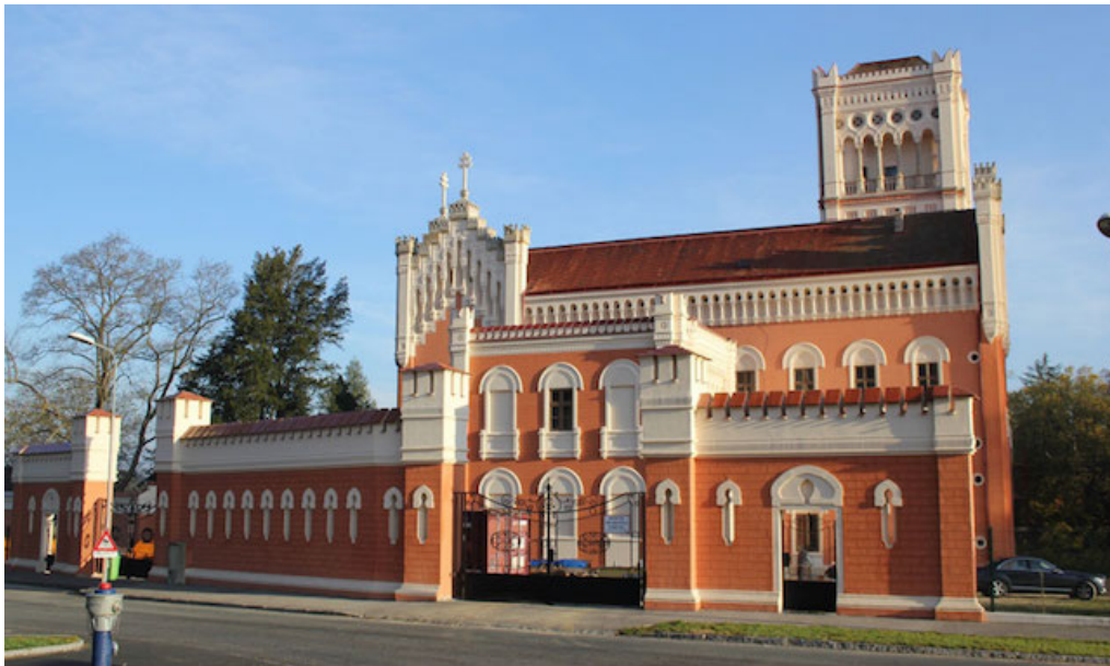
Abb. 107: A. Weber: Schloss Rotenturm, heutiger Zustand nach dem Umbau 1862-1864 und der Restaurierung im 2008.
