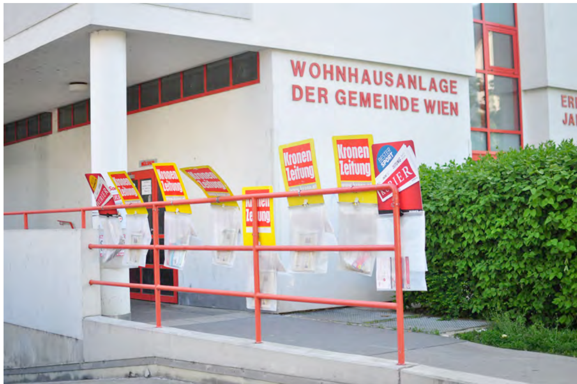
Abbildung 1: Außenansicht, Nordseite (Foto: David Schwarzenbacher)
