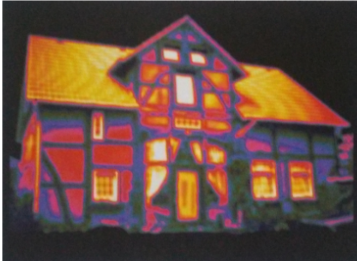
Abbildung 8: Thermogramm eines Hauses (Tipler & Mosca, 2004, S. 627)
