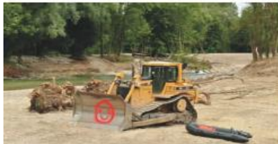
Bau ... freundliche Schubraupe
