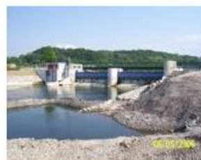
Kraftwerk in der Ybbs bei Kemmelbach
