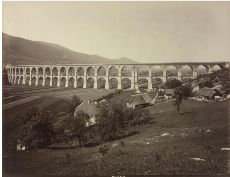
Abbildung 8: Franzdorfer Viadukt in Slowenien. www.bildarchivaustria.at
