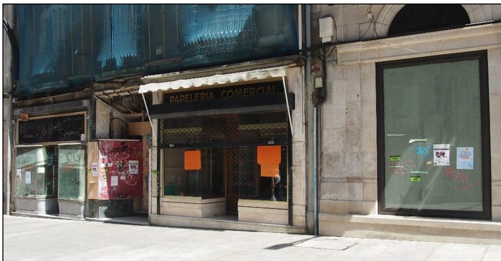
Abb. 36: Leerstehende Geschäftslokale in der Einkaufsstraße von Vigo (Quelle: STECHER, 2015, Vigo)
