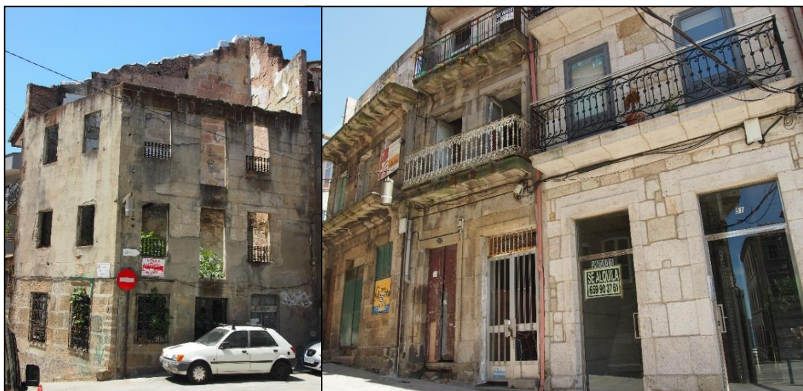
Abb.37: Leerstehende und teils verfallene Immobilien in der Innenstadt von Vigo (Quelle: STECHER, 2015, Vigo)
