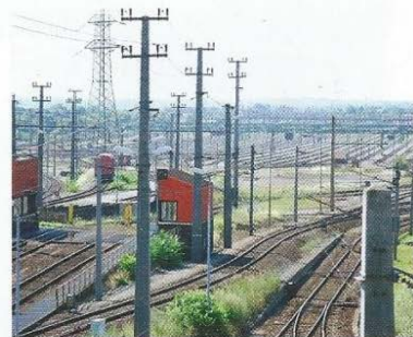
23.4 Am Rangierbahnhof werden die Waggons mithilfe schiefer Ebenen (Abrollhügel) auf eine ausreichend große Geschwindigkeit beschleunigt. Sie rollen dann „antriebslos“ bis zu ihrer Position auf der Gleisharfe.
