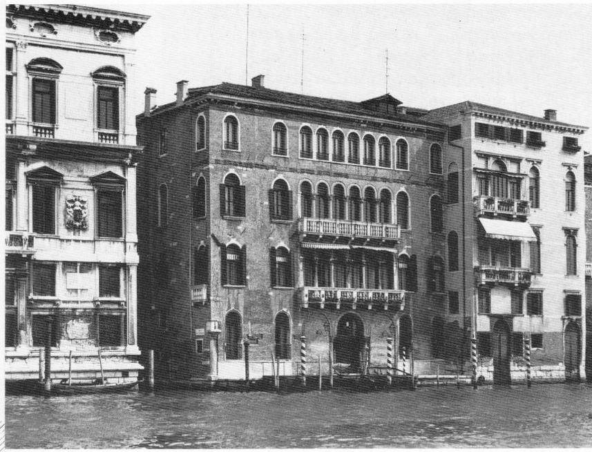
Fig.4.1. Ca' Businello, facciata principale
