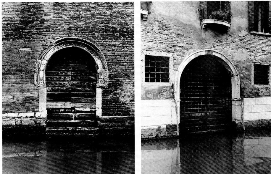
Fig.3.15.a L'evoluzione dell'arco durante il Duecento: "porte d'acqua" di case sui rii di S. Tomà e dei Miracoli
