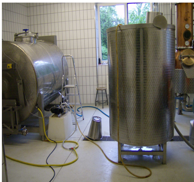
Abb. 13: Kühlung des Rührwerk tanks
