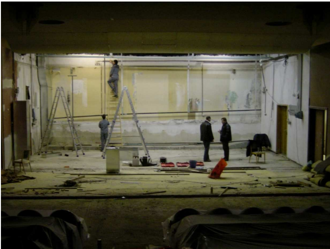
Abbildung 13: Umbau und Renovierung Theatersaal
