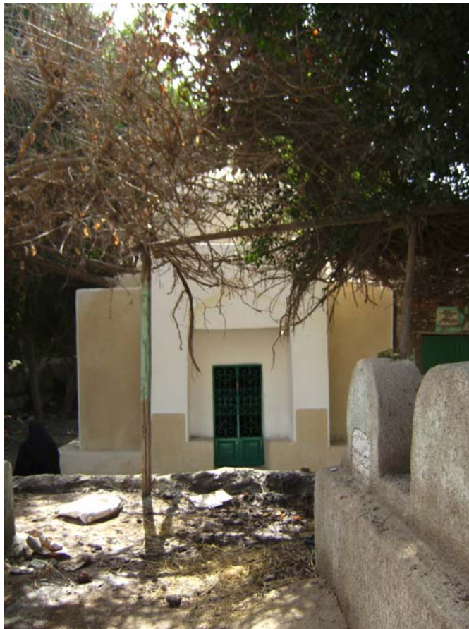
Abb.13: Außenansicht des Schreins des Šayḥ al-Ġunēmī während der Renovierung im März 2008
