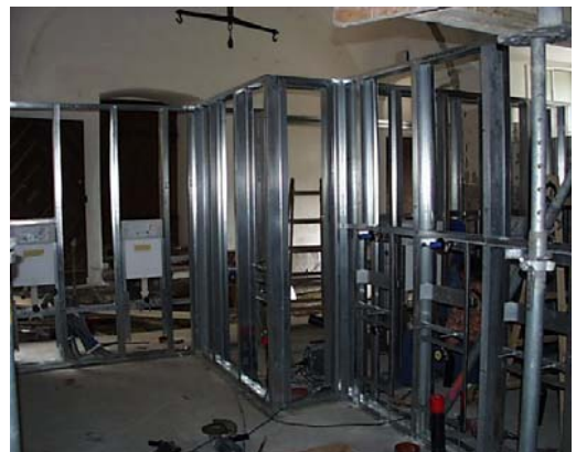
Abb. 13b: Schloss Bruck, Esse: Zustand während der Einbauarbeiten
