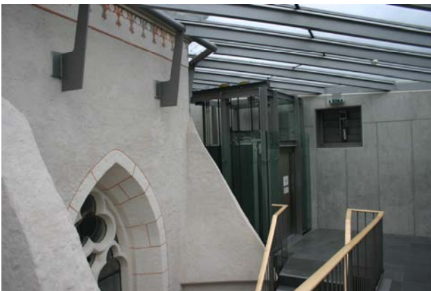
Abb. 135: Wels, Ehemaliger Minoritenkomplex, Aufzugskonstruktion
