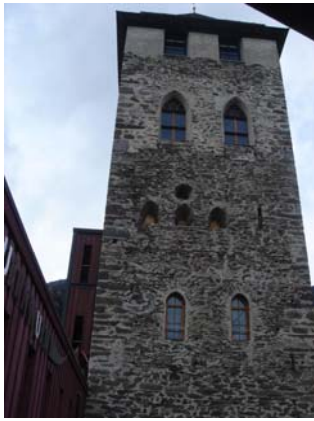
Abb. 27: Winklarn, Mautturm, Ansicht von Süden
