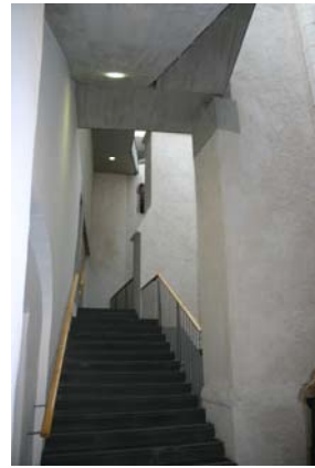
Abb. 134: Wels, Ehemaliger Minoritenkomplex, Treppenkonstruktion
