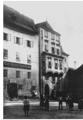
Abb. 47a: Krems, Gozzoburg, Stadtpalais, Fassade um 1900
