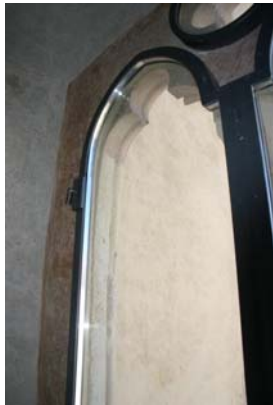
Abb. 67: Krems, Gozzoburg, Fensterverglasung Detail
