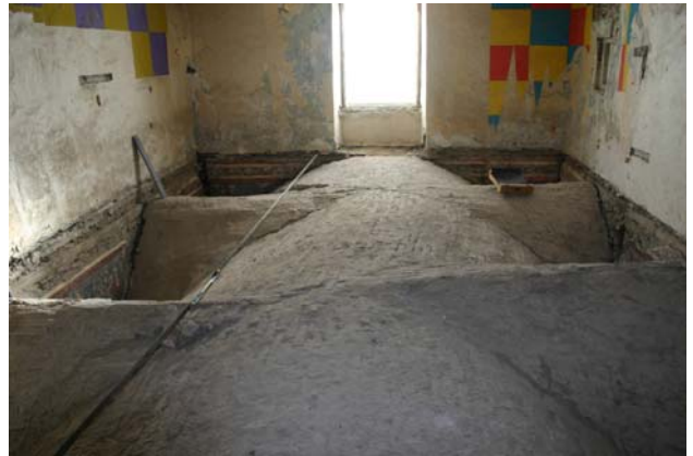
Abb. 60: Krems, Gozzoburg, Turmzimmer während Revitalisierungsarbeiten
