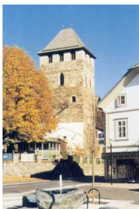
Abb. 36: Winklern, Mautturm, Zustand vor den Revitalisierungsarbeiten
