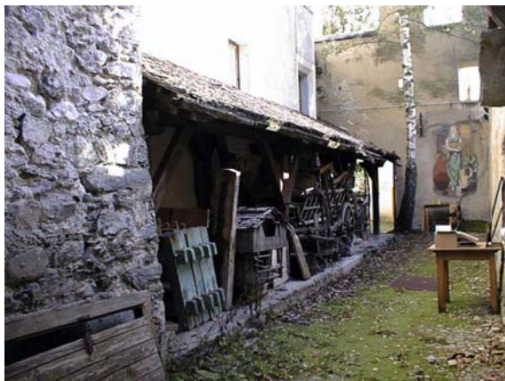
Abb. 18: Schloss Bruck, Innenhof: Zustand vor den Entkernungsarbeiten
