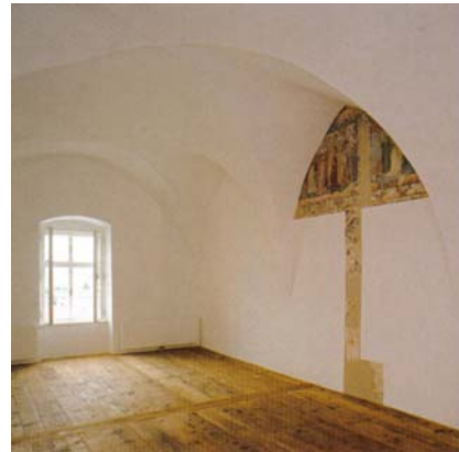
Abb. 62: Krems, Gozzoburg, Turmzimmer unterhalb der Gewölbe
