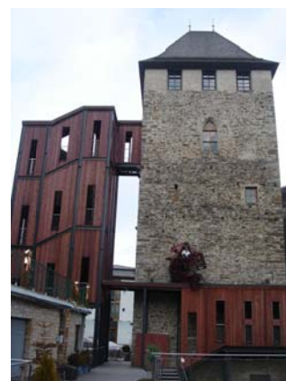
Abb. 26: Winklarn, Mautturm, Ansicht von Osten
