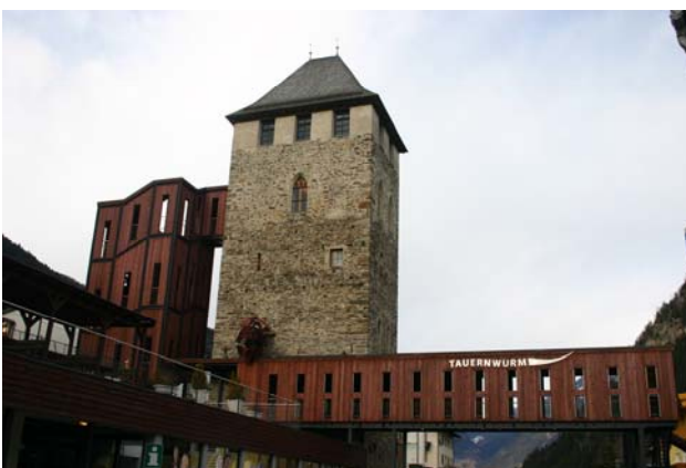
Abb. 31: Winklarn, Mautturm, Gesamtansicht von Südosten
