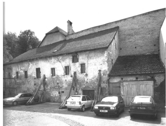
Abb. 125b: Wels, Ehemaliger Minoritenkomplex, Schießhofgebäude vor Adaptierungsarbeiten
