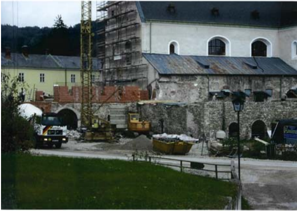
Abb. 77: Kleinmariazell, während der Bauarbeiten
