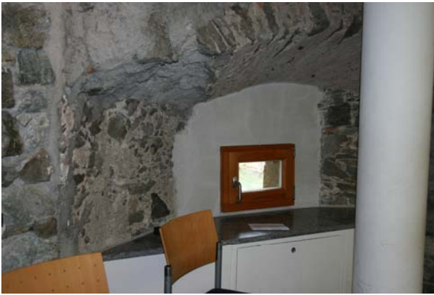
Abb. 94: Radstadt Teichturm, Fenster Detail
