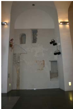
Abb. 119: Wels, Ehemaliger Minoritenkomplex, südliche Kircheninnenwand
