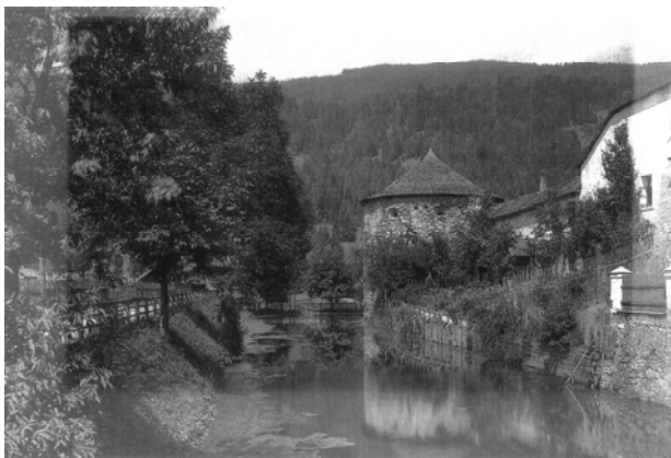
Abb. 91a: Radstadt Teichturm, Ansicht vor Adaptierungsarbeiten
