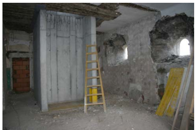
Abb. 64: Krems, Gozzoburg, Wiederöffnung von vermauerten Öffnungen
