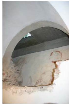
Abb. 128: Wels, Ehemaliger Minoritenkomplex, Südliche Kreuzgangmauer mit Fresko
