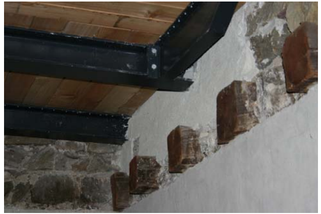
Abb. 38b: Winklarn, Mautturm, Niveauunterschiede
