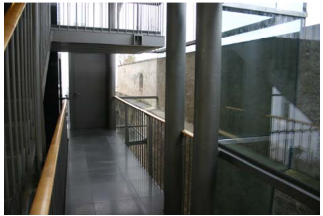
Abb. 124: Wels, Ehemaliger Minoritenkomplex, Foyer Innenansicht Detail
