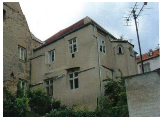
Abb. 53b: Krems, Gozzoburg, Katharinenkapelle vor den Revitalisierungsarbeiten
