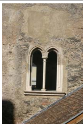
Abb. 44c: Krems, Gozzoburg, Stadtpalais, Rekonstruktion der Biforienfenster
