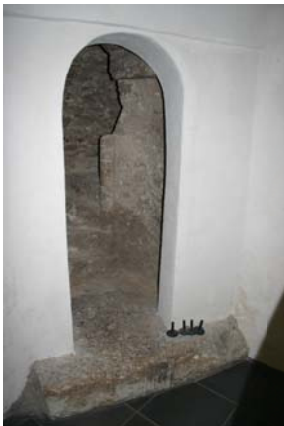
Abb. 129: Wels, Ehemaliger Minoritenkomplex, Eingang in Wendeltreppe
