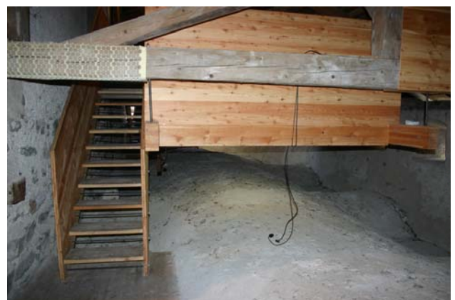
Abb. 15: Schloss Bruck, Eingehängtes Geschoss
