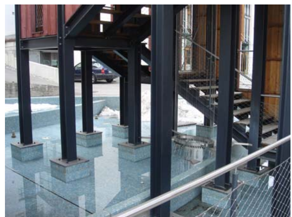
Abb. 32: Winklarn, Mautturm, Wasserbecken
