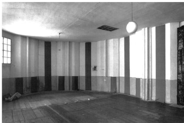
Abb. 114: Wels, Ehemaliger Minoritenkomplex, Chor vor Abbruch der Zwischengeschosse
