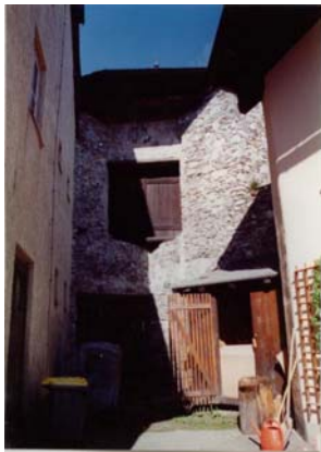
Abb. 96: Radstadt Teichturm, Außenansicht vor Adaptierungsarbeiten
