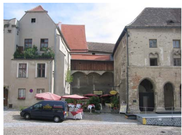
Abb. 49a: Krems, Gozzoburg, Zustand vor eingefüater Konstruktion
