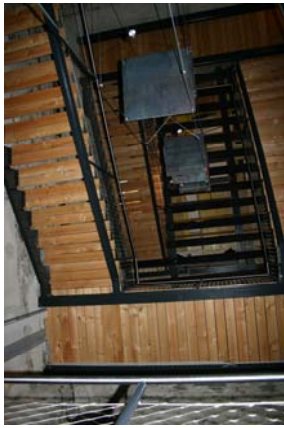
Abb. 33: Winklern, Mautturm, Eingestellte Treppenkonstruktion
