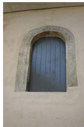
Abb. 43: Krems, Gozzoburg, Rundbogenportal des Kernbaues
