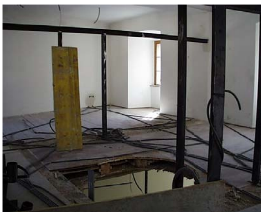
Abb. 20a: Schloss Bruck, Verwaltungstrakt: Bau der Verbindungstreppe
