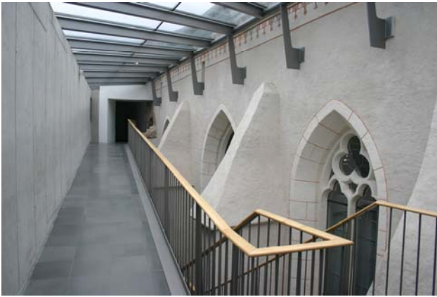
Abb. 133: Wels, Ehemaliger Minoritenkomplex, Dachgeschoss
