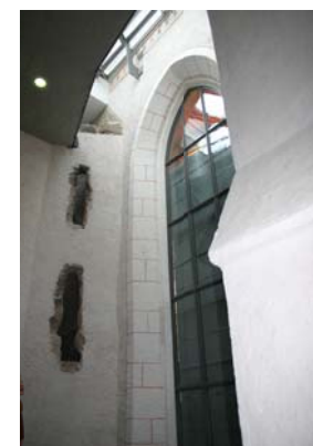
Abb. 132: Wels, Ehemaliger Minoritenkomplex, Treppenturm
