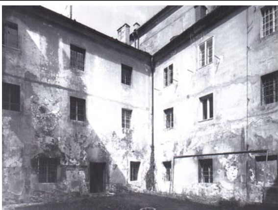
Abb. 126a: Wels, Ehemaliger Minoritenkomplex, Kreuzgang vor Adaptierungsarbeiten
