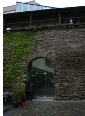
Abb. 72: Krems, Mauerdurchbruch Detail
