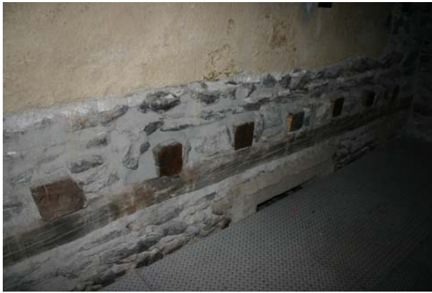
Abb. 38a: Winklarn, Mautturm, Niveauunterschiede
