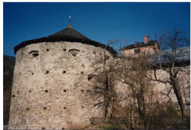
Abb. 91b: Radstadt Teichturm, Ansicht vor Adaptierungsarbeiten
