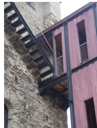
Abb. 30: Winklarn, Mautturm, Überbaute historische Steinstufen
