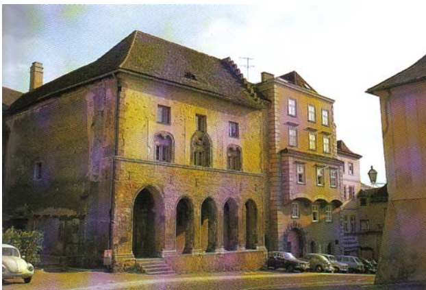
Abb. 47b: Krems, Gozzoburg, Stadtpalais, Fassade nach 1956
