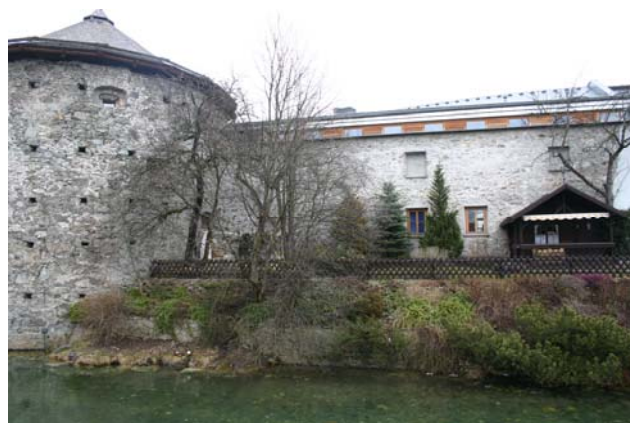
Abb. 88: Radstadt Teichturm, Ansicht mit Stadtmauer
