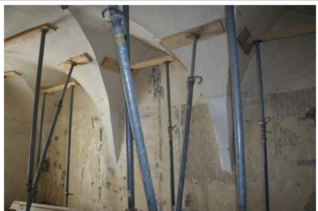
Abb. 58: Krems, Gozzoburg, Turmzimmer während Revitalisierungsarbeiten
