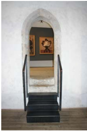
Abb. 21: Schloss Bruck, Freigelegte Spitzbogenöffnung
