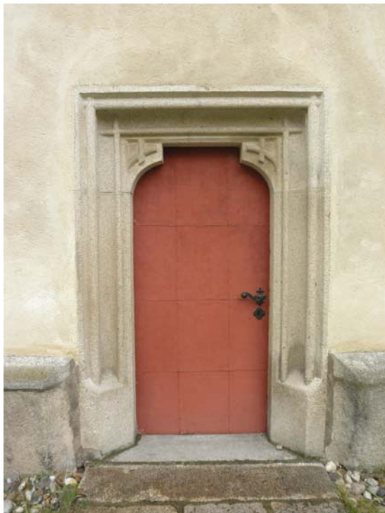
Abb.39: Türportal an Südseite
