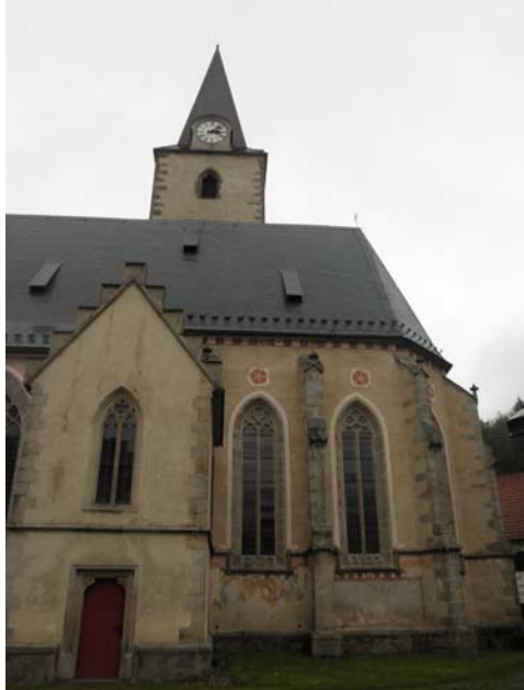
Abb. 37: Außenansicht Südseite Chor
