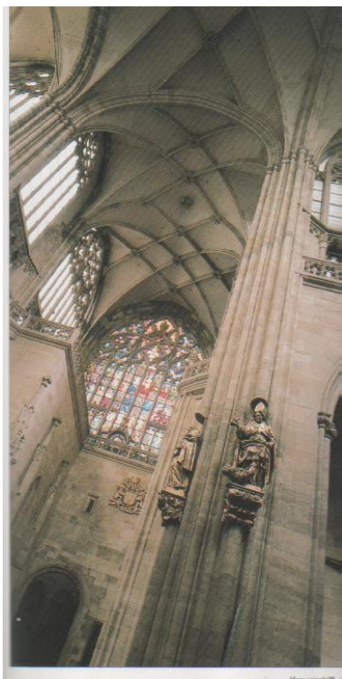
Abb. 10: Veitsdom Blick in die Vierung Burg
