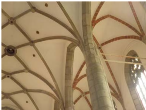
Abb.33 : Gewölbedetail Langhaus- Seitenschiff
