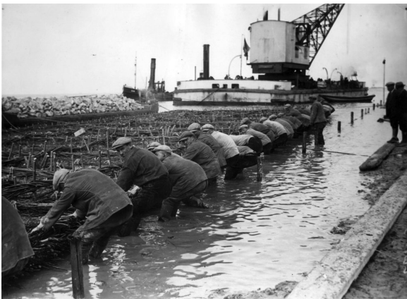
Abbildung 3.5: Weidenrutenmatten beim Bau des Afsluitdijks. Originalbildbeschreibung: Bouw van de Afsluitdijk in april 1932: Kraagstukken van gevlochten [riet of wilgetakken] worden op de kleibasis gehesen en daarna met granietblokken (op de achtergrond) verzwaaard. Collectie Sparnestadt, Rijksarchiv, Den Haag
