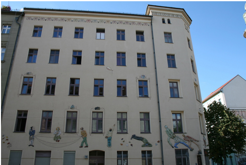
Abbildung 10: Fassadengestaltung Adalbertstraße, Hanefi Yeter 1984, 2000 restauriert, Berlin Kreuzberg
