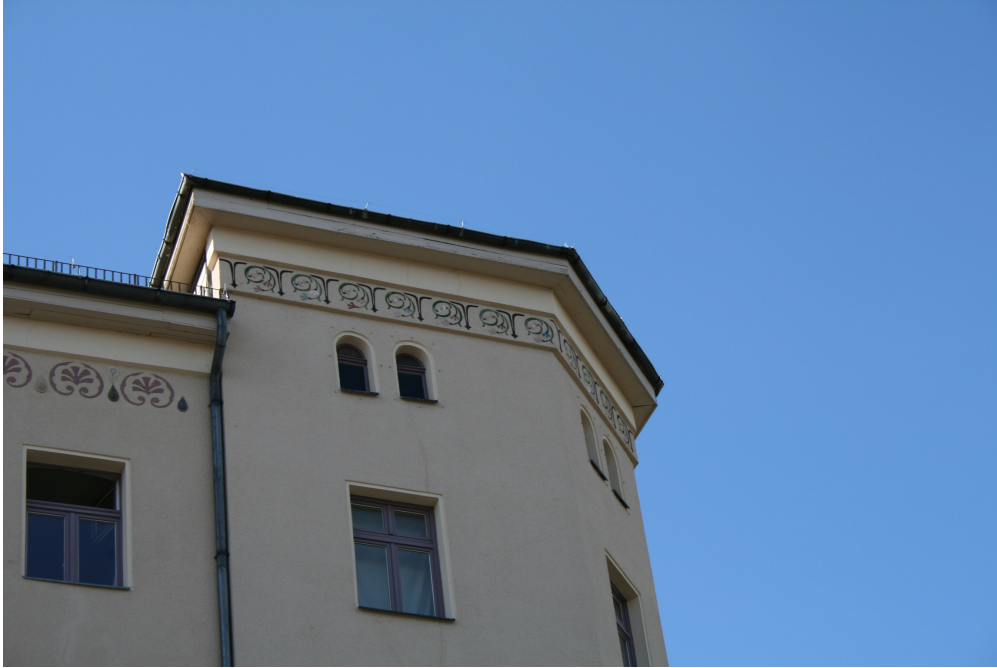
Abbildung 13: Fassadengestaltung Adalbertstraße, Hanefi Yeter 1984, 2000 restauriert, Berlin Kreuzberg
