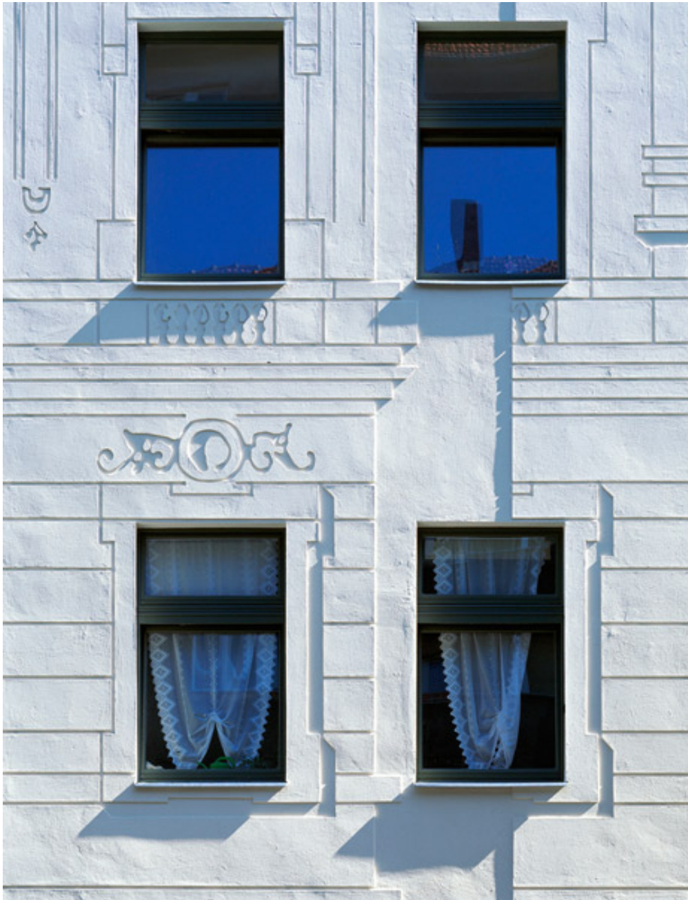
Abbildung 4: Fassadensanierung Belzigerstraße, Hild und K 1999, Berlin Schöneberg
