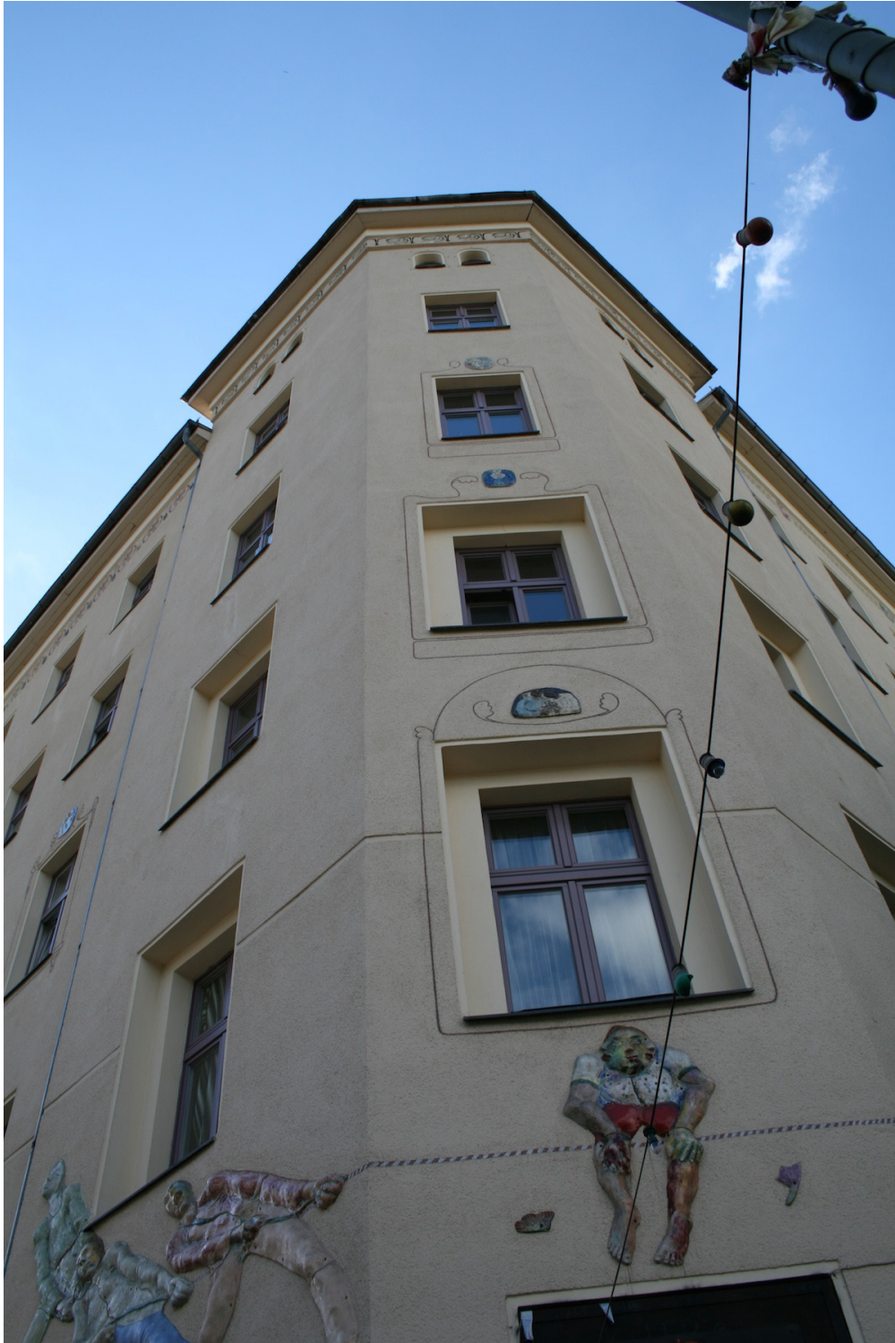
Abbildung 11: Fassadengestaltung Adalbertstraße, Hanefi Yeter 1984, 2000 restauriert, Berlin Kreuzberg
