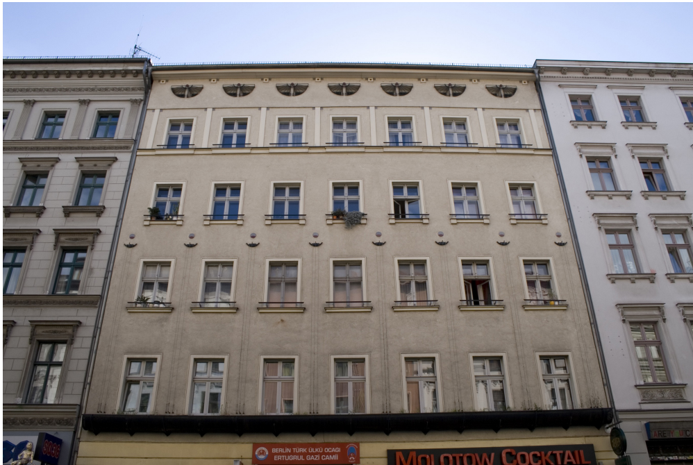
Abbildung 34: Gestänge zur Fassadenbegrünung, Berlin Kreuzberg
