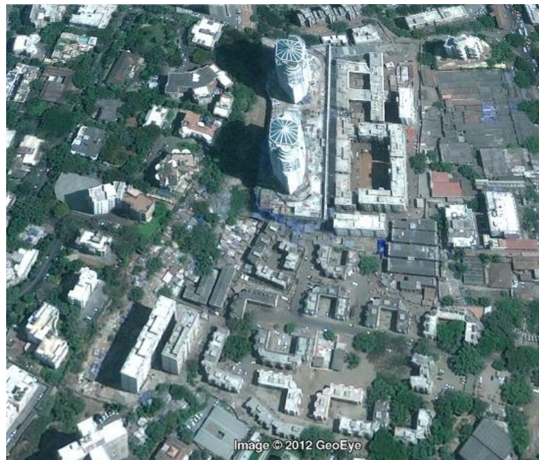
Abbildung 2: Das Projekt nach Fertigstellung, Satellitenbild vom 03.05.2010
