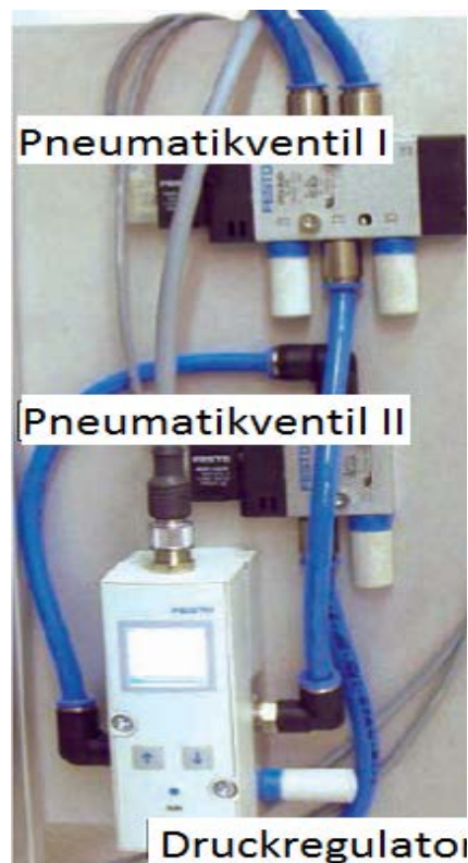
Abbildung 13: Druckregulator mit den beiden Pneumatikventilen
