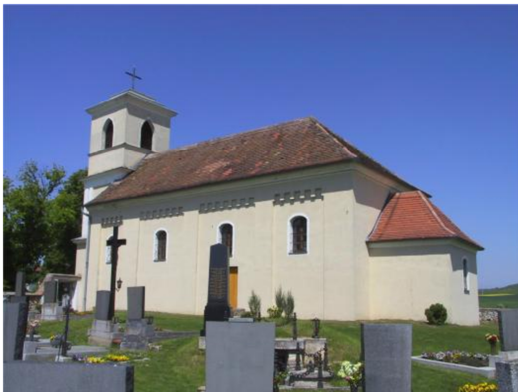
Abb. 26. Seitenansicht, Filialkirche St. Ulrich bei Neusiedl a. d. Zaya, NÖ.
