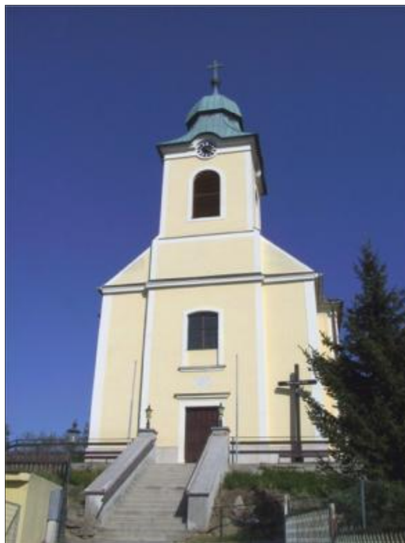
Abb. 20. Außenansicht, Pfarrkirche Obergänserndorf, NÖ.
