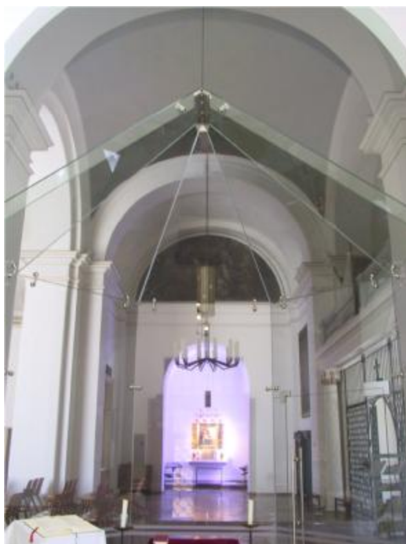
Abb. 44. Innenansicht des Altbestandes, Pfarrkirche Hinterbrühl, NÖ.
