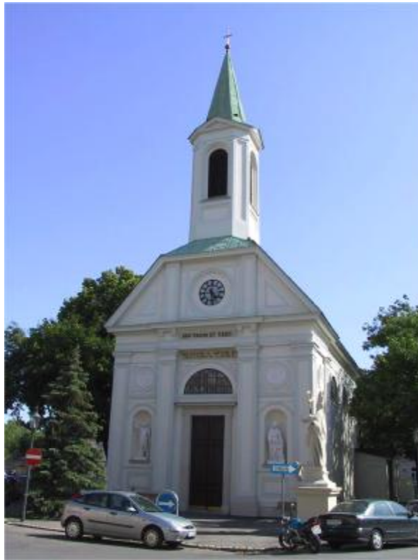
Abb. 49. Außenansicht, Pfarrkirche Altmannsdorf, Wien XII.
