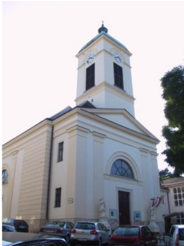
Abb. 31. Außenansicht, Pfarrkirche Döbling, Wien XIX.
