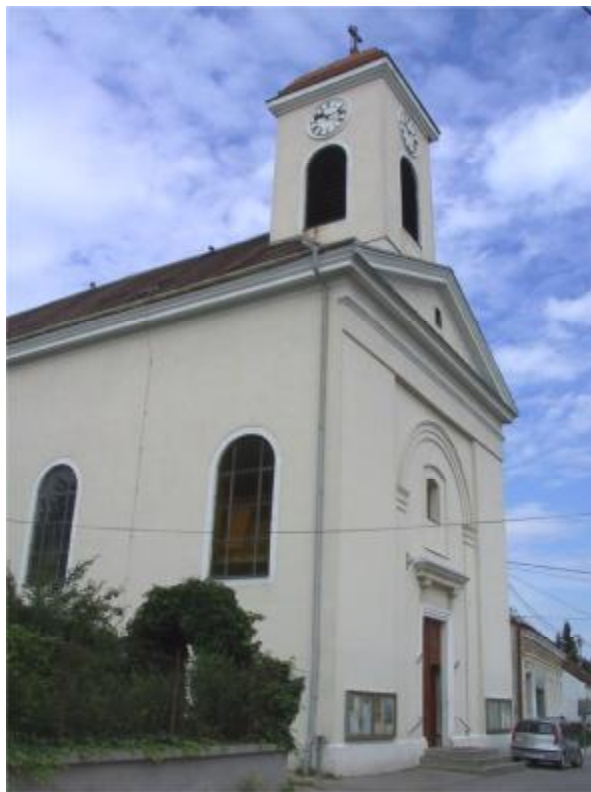
Abb. 28. Außenansicht, Pfarrkirche Breitenwaida, NÖ.
