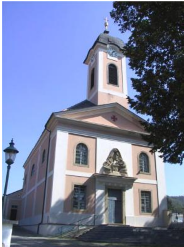
Abb. 17. Außenansicht, Pfarrkirche Reidling, NÖ.
