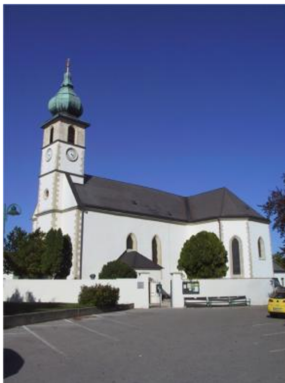
Abb. 120. Außenansicht, Pfarrkirche Trumau, NÖ.
