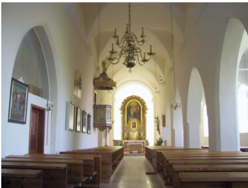
Abb. 102. Innenansicht, Pfarrkirche Mittergrabern, NÖ.
