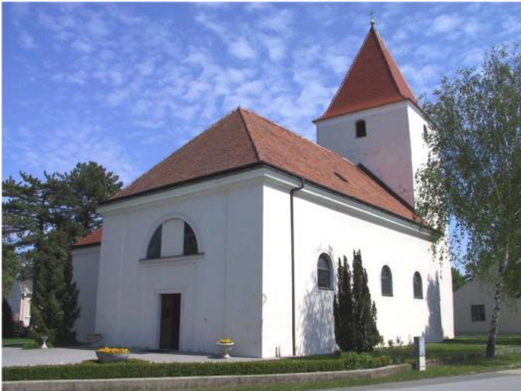
Abb. 75. Außenansicht, Pfarrkirche Haringsee, NÖ.
