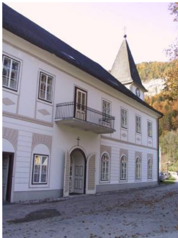
Abb. 124. Außenansicht, Evang. Pfarrkirche Naßwald, NÖ.
