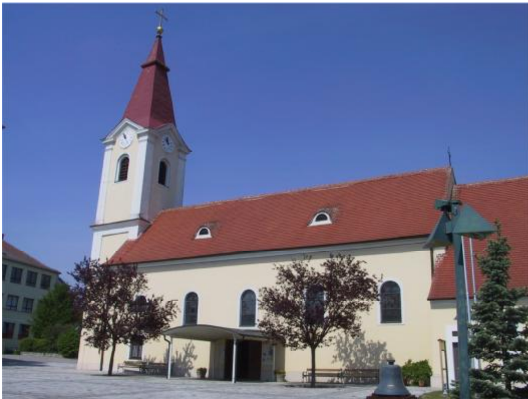
Abb. 107. Seitenansicht, Pfarrkirche Ziersdorf, NÖ.
