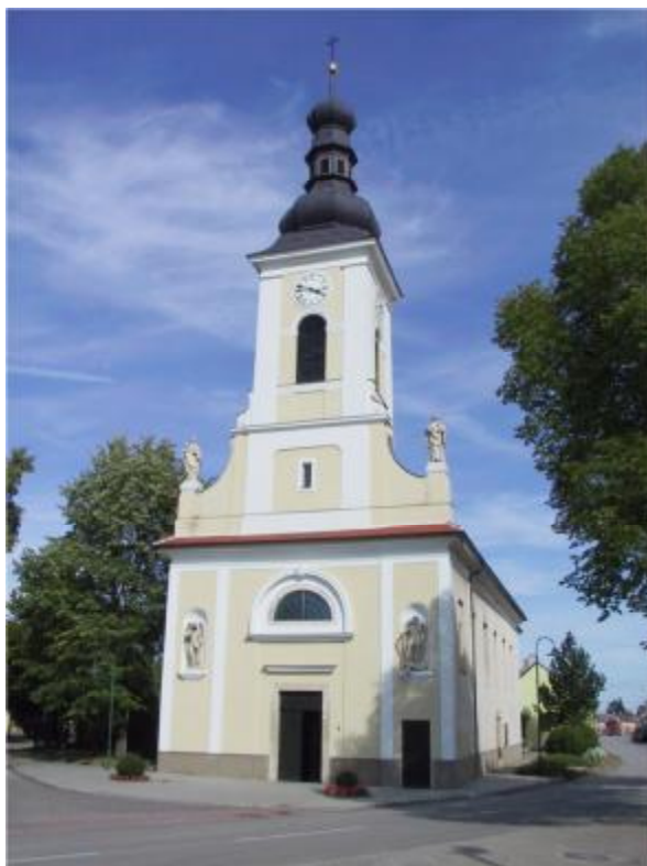
Abb. 105. Außenansicht, Pfarrkirche Obritz, NÖ.
