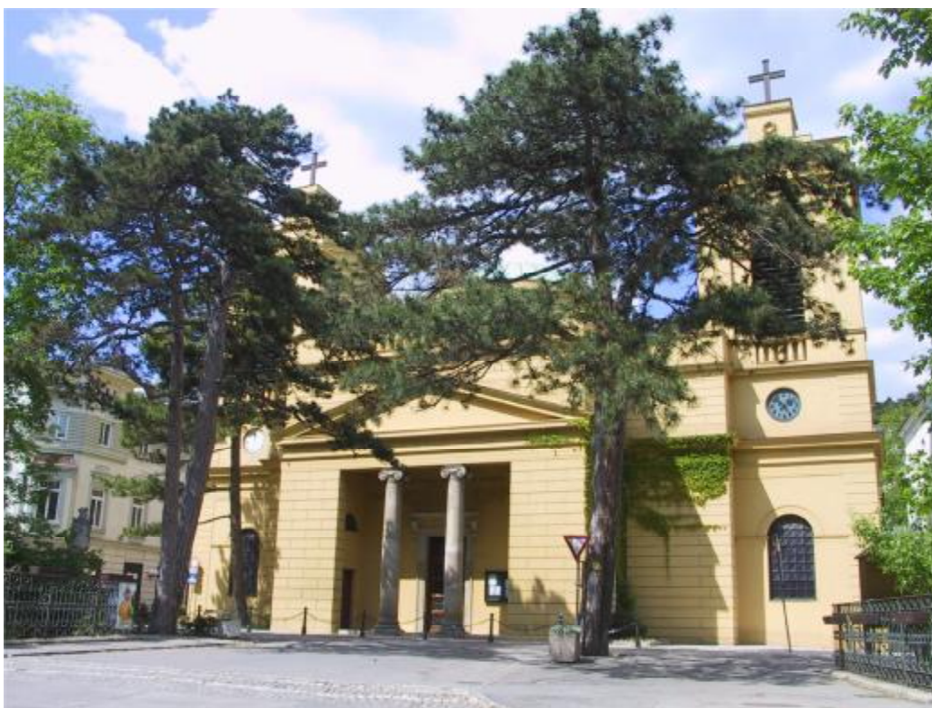
Abb. 42. Außenansicht, Pfarrkirche Hinterbrühl, NÖ.
