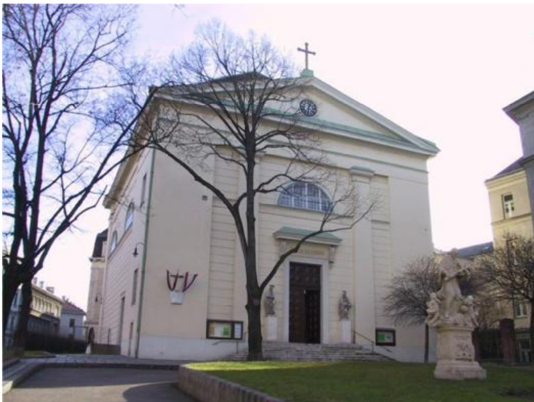
Abb. 86. Außenansicht, Pfarrkirche Erdberg, Wien III.
