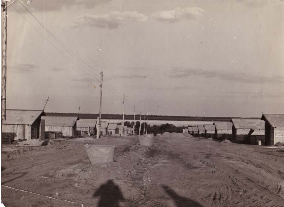
Abb. 7: In Bau befindliche Ställe der Geflügelzucht an der Ostseite des Dorfes Dokutschaewo, o.J., vermutlich Anfang 1980er Jahre, 1994 nur noch teilweise in Betrieb
