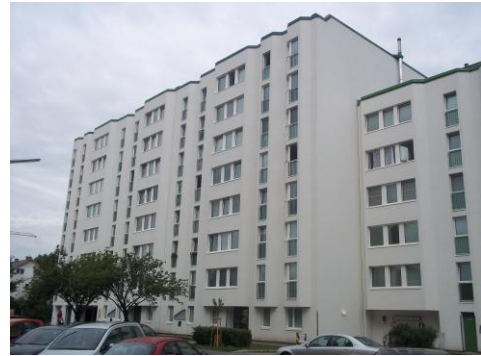
Abbildung 3: Wohnhausanlage Pastorstraße 22 - Fassade neu © Bettina Steiner
