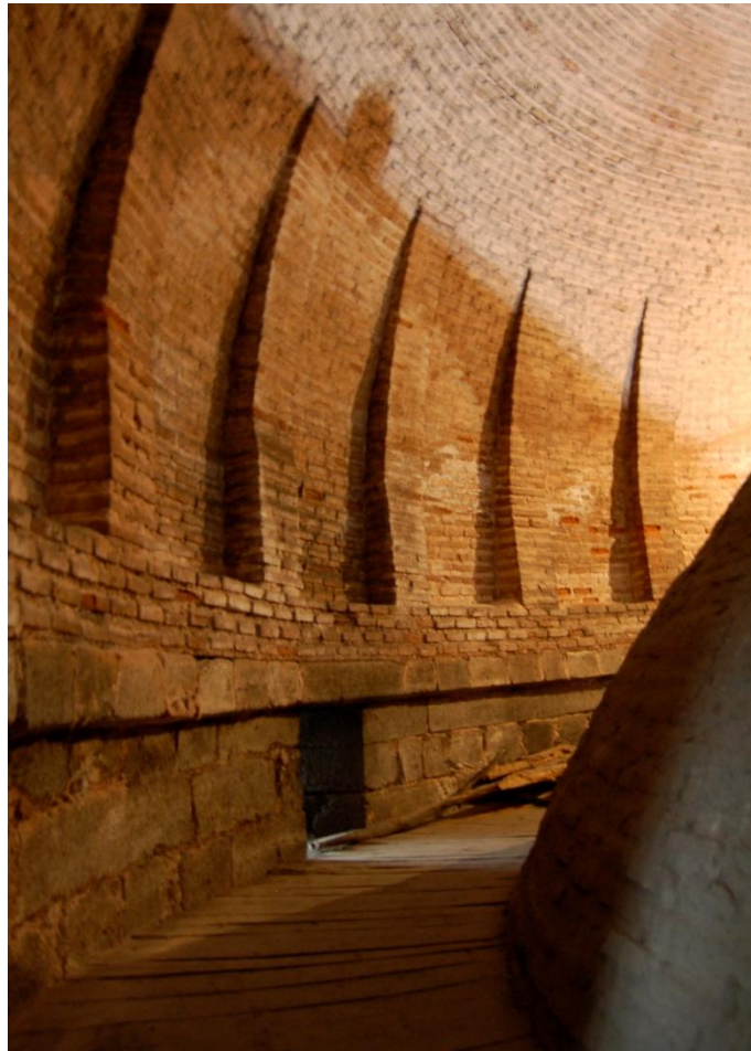
Abb. 56: Doppelschalige Ziegelkuppel, Süleyman I. Mausoleum, 1566, Istanbul, Türkei.
