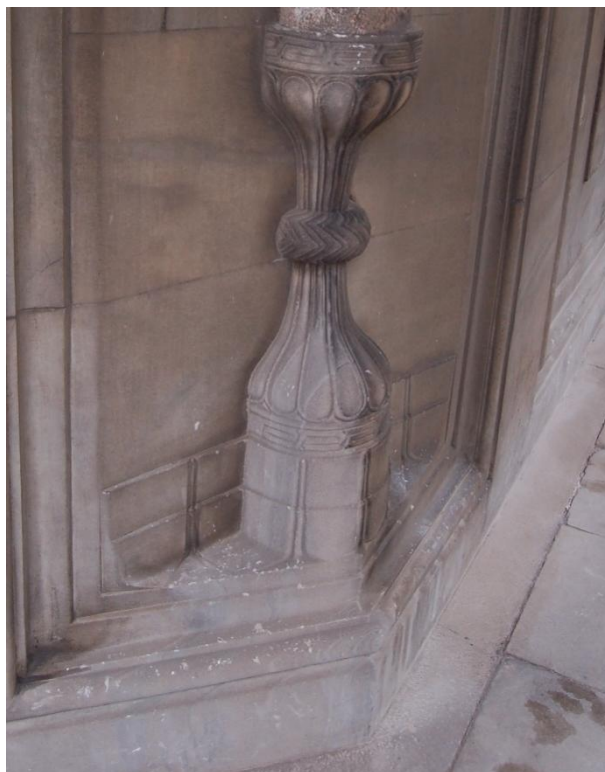
Abb. 55: Abgeflachte Ecken des äußeren Oktogons, Süleyman I. Mausoleum, 1566, Istanbul, Türkei.
