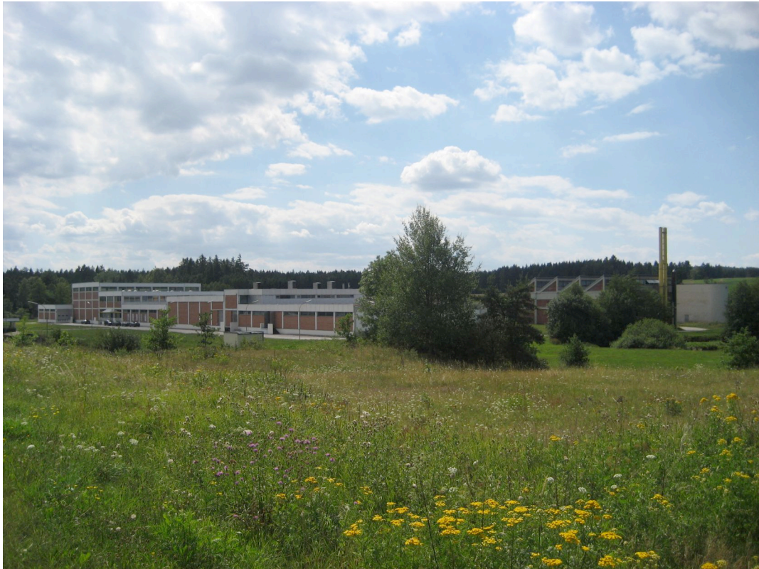
Abbildung 3: Das 1974 eröffnete Werk 2 der Frottierweberei Amstetter an der Schremser Straße in Heidenreichstein.
