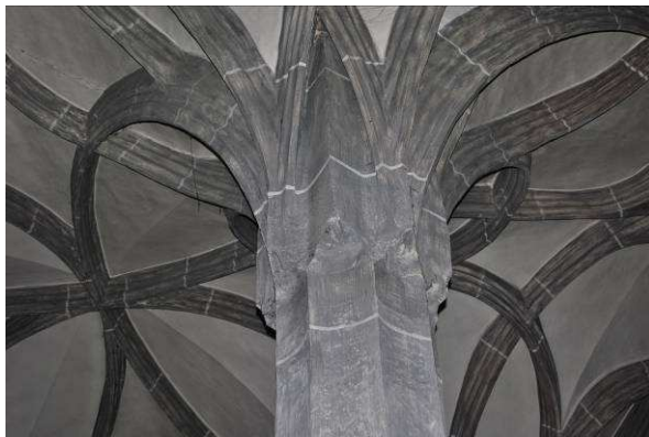
Abb. 21: Pfarrkirche Weistrach Pfeilerkopf (Alfred Fischeneder 2010)
