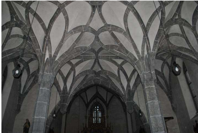
Abb. 19: Pfarrkirche Weistrach Blick Richtung Osten (Alfred Fischeneder 2010)
