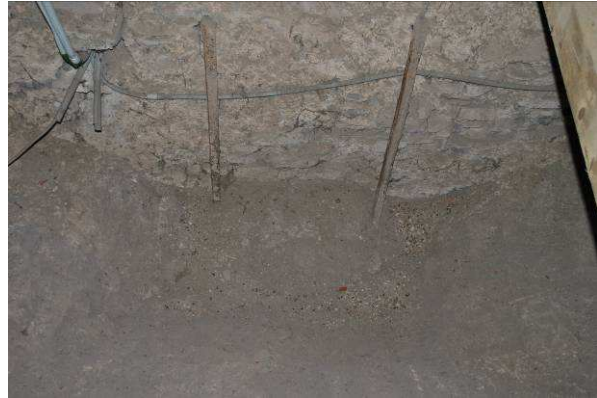
Abb. 120: Pfarrkirche Weistrach Dachboden Klammern für die Befestigung der hängenden Rippenanläufe (Alfred Fischeneder 2010)
