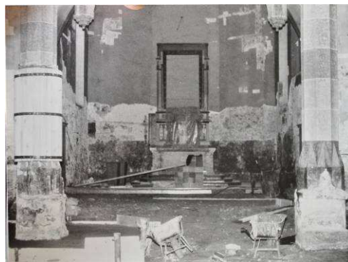
Abb. 146: Pfarrkirche Weistrach Fundamentierung (Foto Pfarrarchiv)
