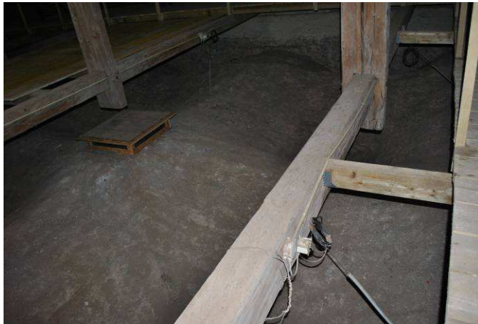
Abb. 121: Pfarrkirche Weistrach Dachboden spätgotischer Gewölbetrichter (Alfred Fischeneder 2010)
