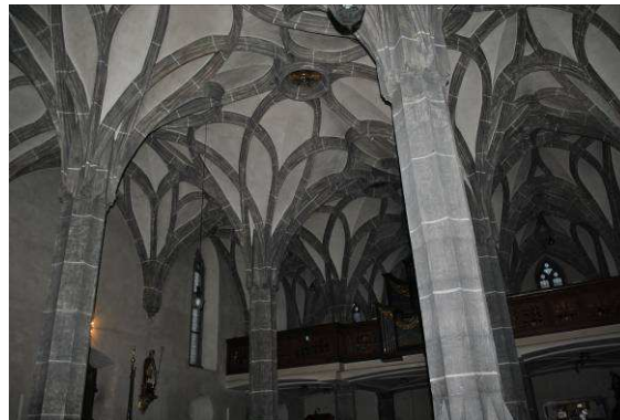
Abb. 30: Pfarrkirche Weistrach Langhausgewölbe (Alfred Fischeneder 2010)
