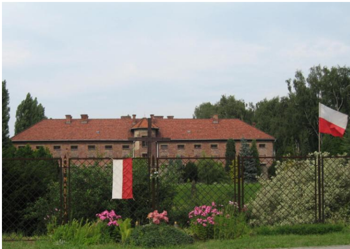
Abbildung 13: Garten des ehemaligen Theatergebäudes, Foto: KC, Juli 2009
