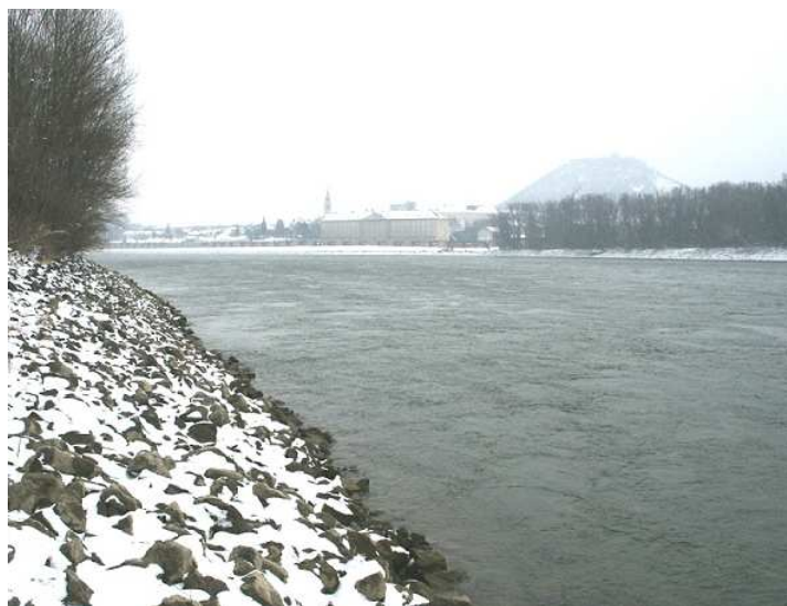
Abbildung 3: Probenstelle Blockwurfgesichertes Prallufer bei km 1885,30; Photo: Verfasser
