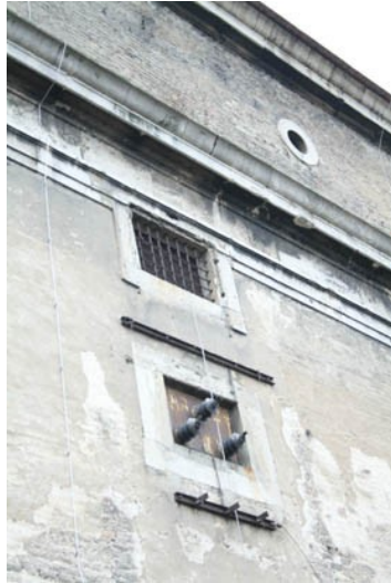
Abbildung 45: Traforeste außen (Südmauer des Schlosses Neugebäude)
