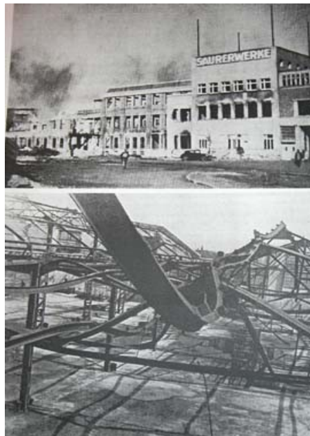
Abbildung 41: Schäden des Zweiten Weltkrieges am Firmengelände des Saurer – Werkes
