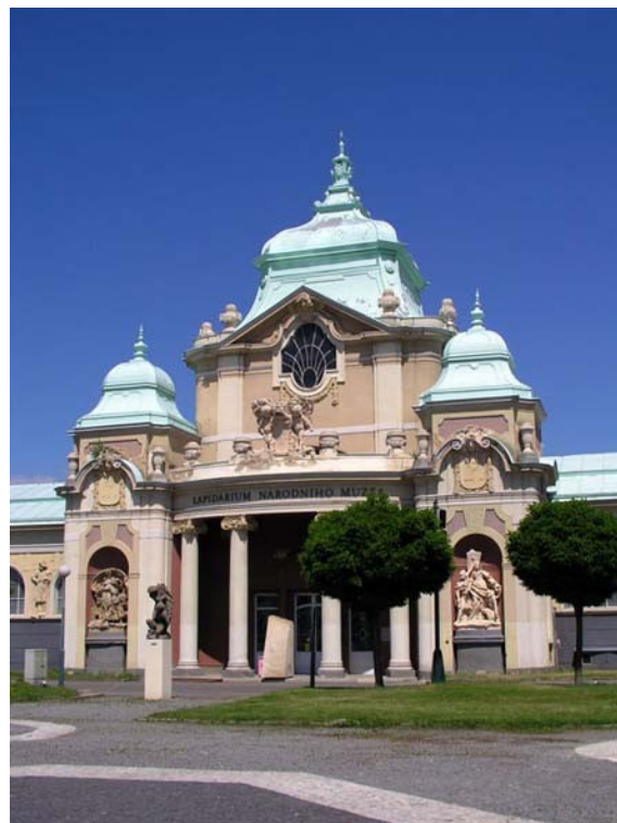
Abbildung 56: Lapidarium Prag, Außenansicht
