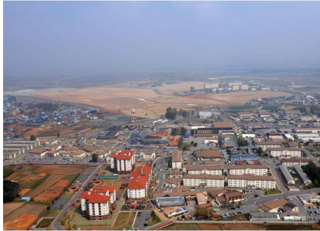
Abbildung 4: Baufortschritt im Camp Humphreys
