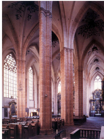
Abb.52 Neuberg/Mürz, Zisterzienserkirche, Langhaus, Pfeiler
