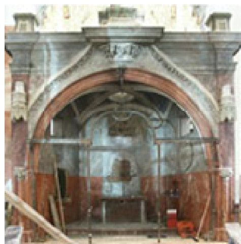
Abb.48 Marizell, Wallfahrtskirche, Gnadenkapelle, Aufnahme der Restaurierungsarbeiten 2002
