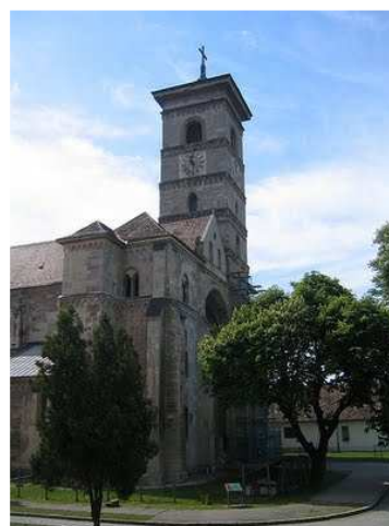
Abb.57 Alba Iulia (dt. Karlsburg), Dom, Ansicht von Nordwesten
