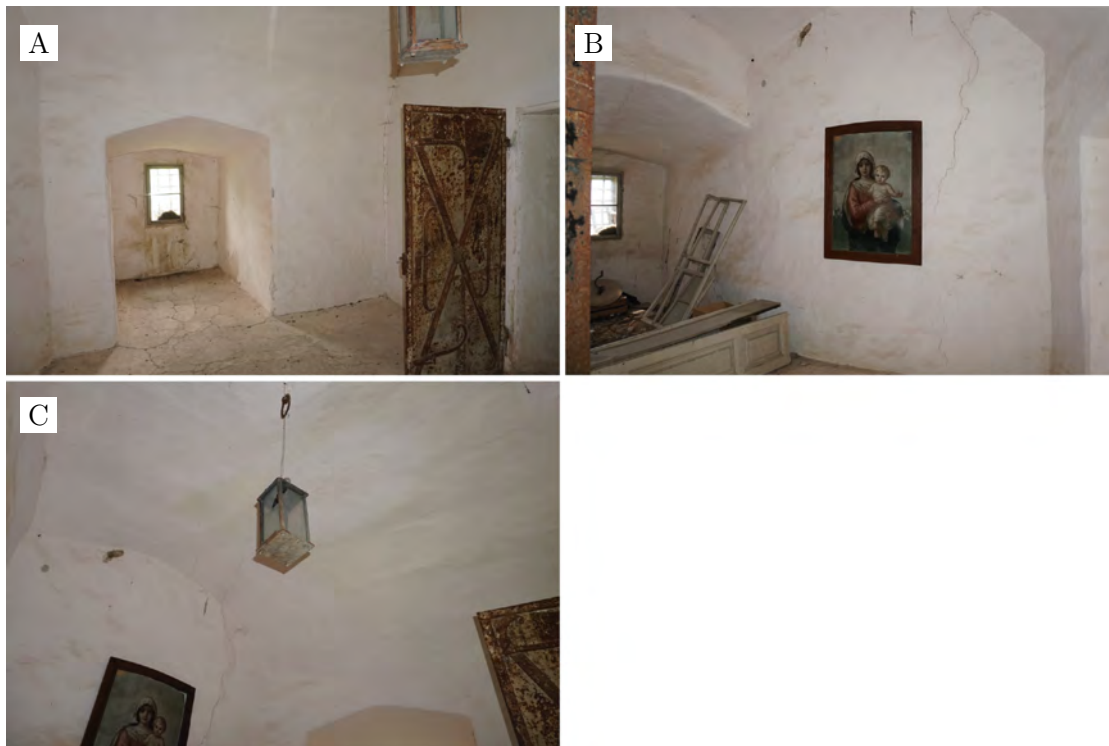
Abbildung A.19.: Ansichten des Westraums, 1. Obergeschoss: Nordseite mit Fenster und rezenter Eisentür (A); Südwestseite mit Südfenster und Mariengemälde (B); Gewölbe (C).
