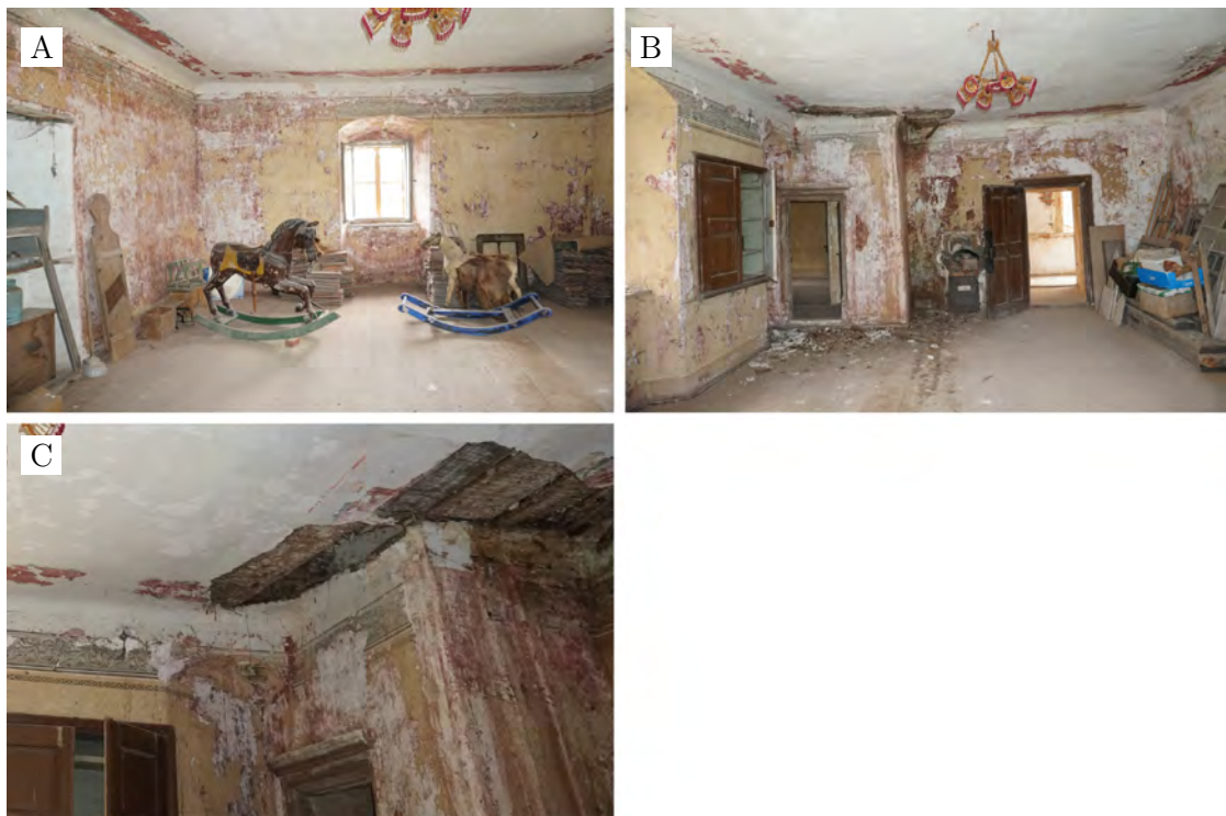
Abbildung A.29.: Ansichten des Torwarts: Nordseite mit Fenster und rezenter Einrichtung (A); Südseite mit Eingängen zur Galerie und Bergfried (B); hölzerne Flachdecke mit abgeplatzttem Verputz (C).
