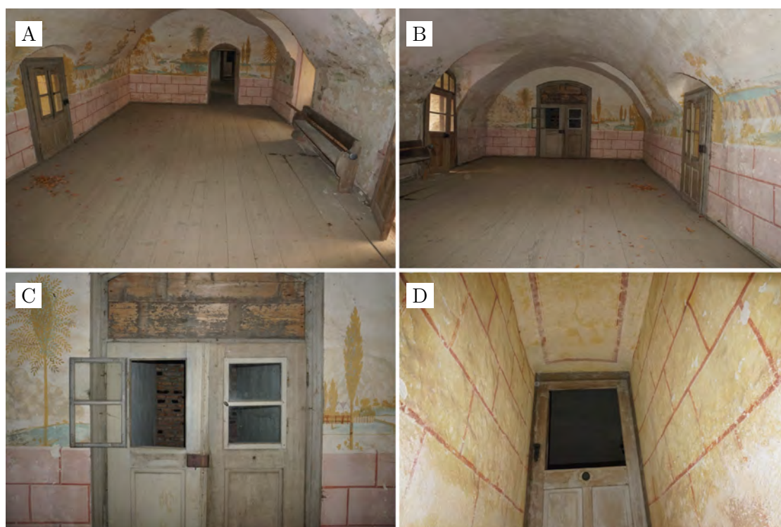
Abbildung A.20.: Ansichten des Theatersaals: Westseite (A); Ostseite (B); ehemaliger Durchgang Ostseite (C); ehemaliger Durchgang Südseite (D).
