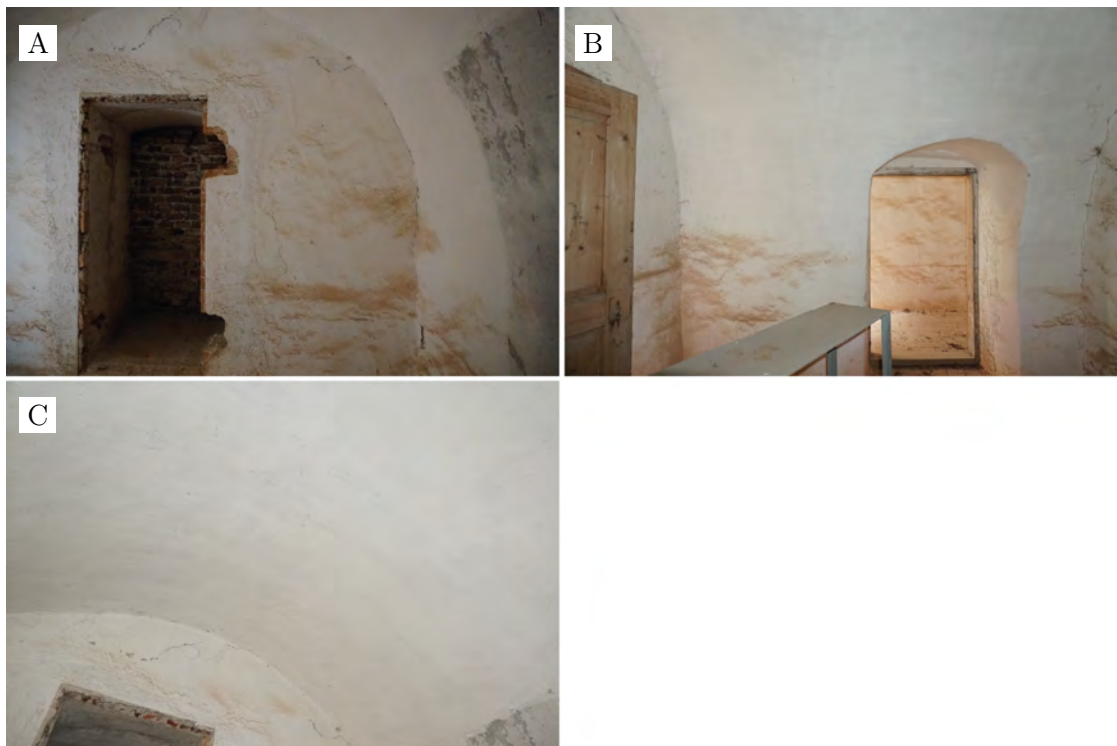
Abbildung A.26.: Ansichten des Ostraums, 1. Obergeschoss: Ostseite mit zugemauertem Durchgang zum Schlosshof (A); Westseite mit Eingang zur Galerie (B); verputztes Tonnengewölbe (C).
