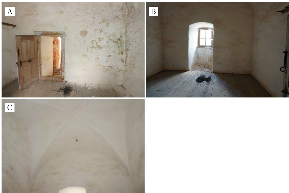
Abbildung A.52.: Ansichten des Turms, 3. Obergeschoss: Westseite (A); Ostseite (B); Gewölbe (C).
