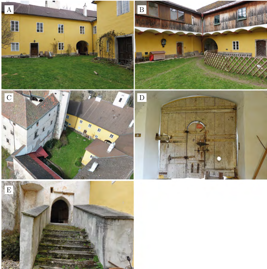
Abbildung A.58.: Engelstein: Ansichten des Schlosshofs: Nordseite (A); Südseite (B); Vogelperspektive von der Südseite (C); Eingangstor zum Schlosshof an der Südseite, Innenansicht (D). Ausgang und Burgtor an der Westseite (E).
