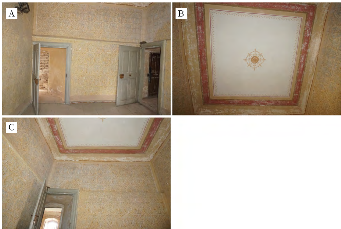
Abbildung A.22.: Ansichten des ersten Turmgeschosses: Westseite (A); Flachdecke (B); Nordseite (C).
