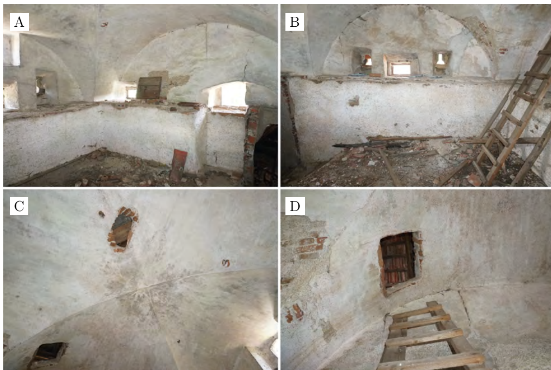
Abbildung A.54.: Ansichten des obersten Turmgeschosses: Südostseite (A); Nordostseite (B); Gewölbe (C); Aufgang zum Dachstuhl (D).
