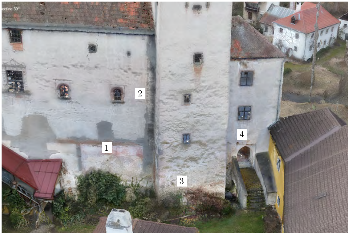
Abbildung 3.32.: Texturierte Vermaschung des Schlosshofs: Ehemaliger Wehrgang (1); Ehemaliger Schornstein (2); Zugang Kerker (3); Eingang mit ehemaligem Burggraben und Scharte für Zugbrücke (4).
