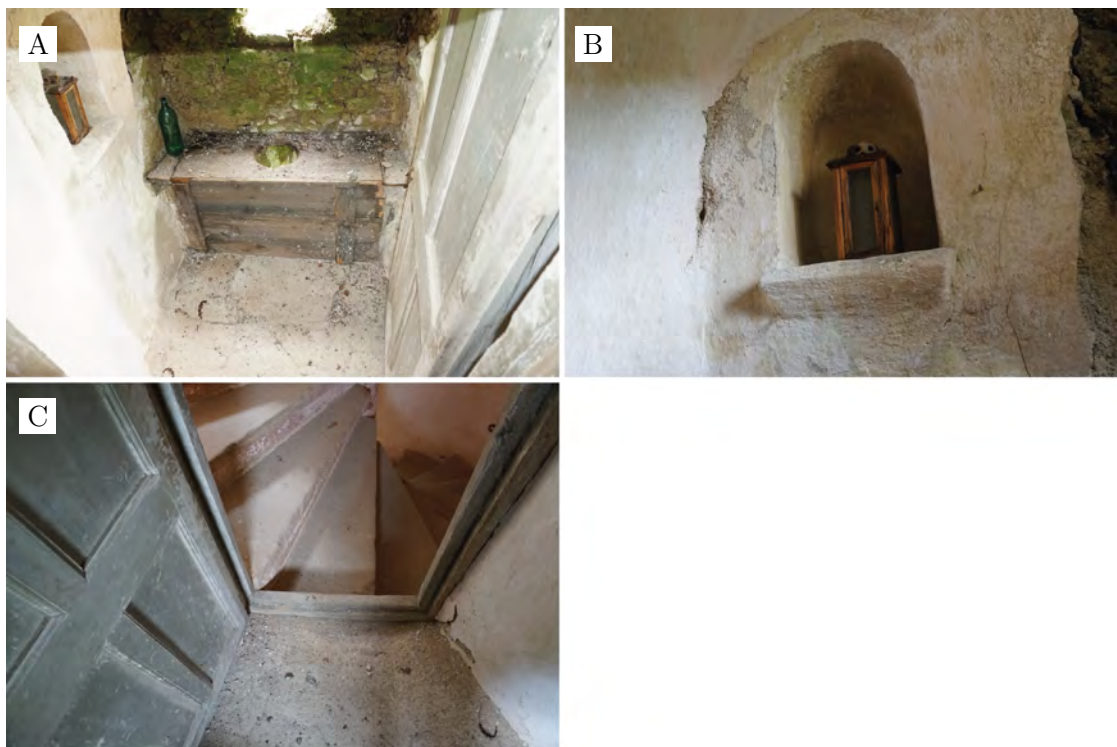
Abbildung A.34.: Ansichten des Aborts, 2. OG: Nordseite (A); Westseite mit Nische (B); Südseite mit Stiegenhaus (C).
