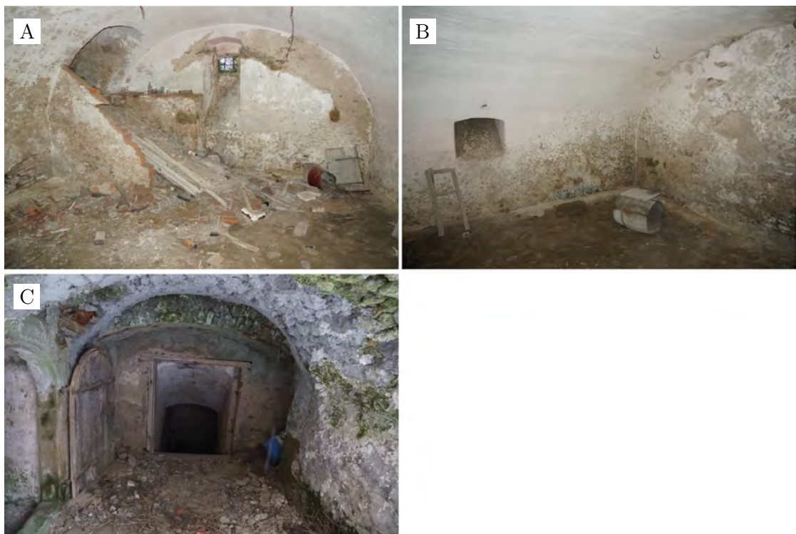
Abbildung A.4.: Ansichten des Kellerraums Ost: Südostseite (A); Nordostseite (B); Eingang Südseite (C).
