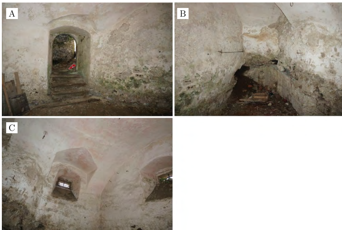
Abbildung A.2.: Ansichten des nördlichen Kellerraums: Eingang ostseitig (A); Nische Südseite (B); Fenster nord- und westseitig (C).
