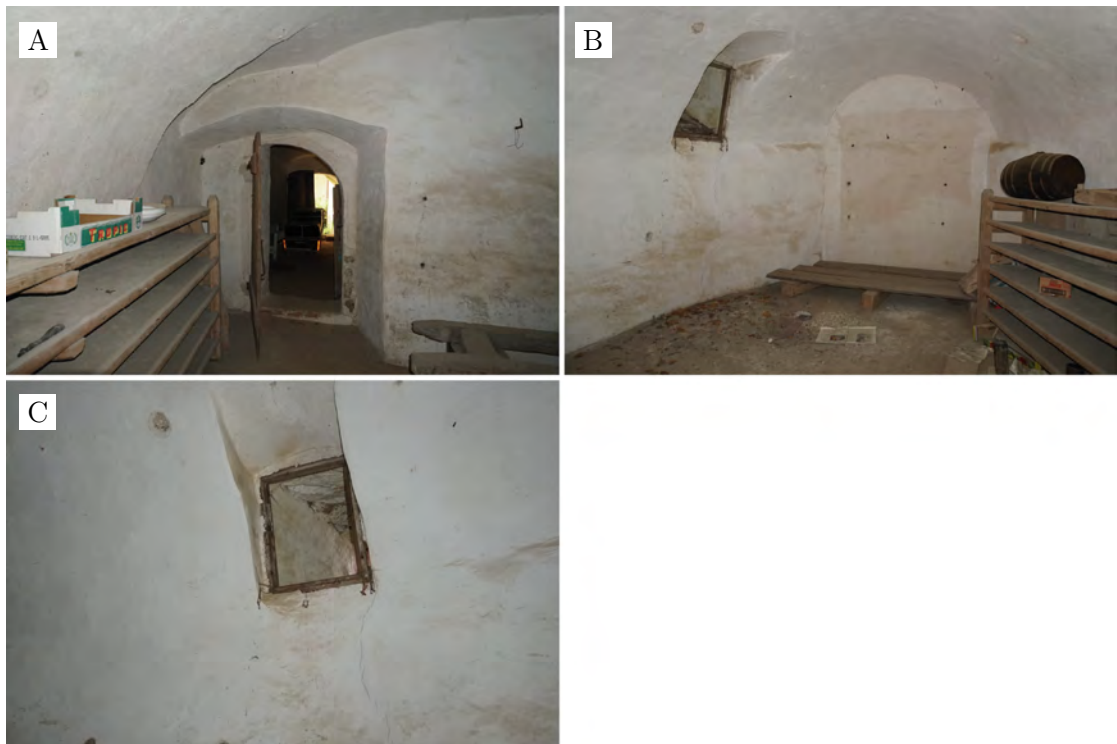
Abbildung A.11.: Ansichten des westlichen Kellerraums: Ostseite mit Eingang (A); Westseite (B); Südseite mit Fenster (C).
