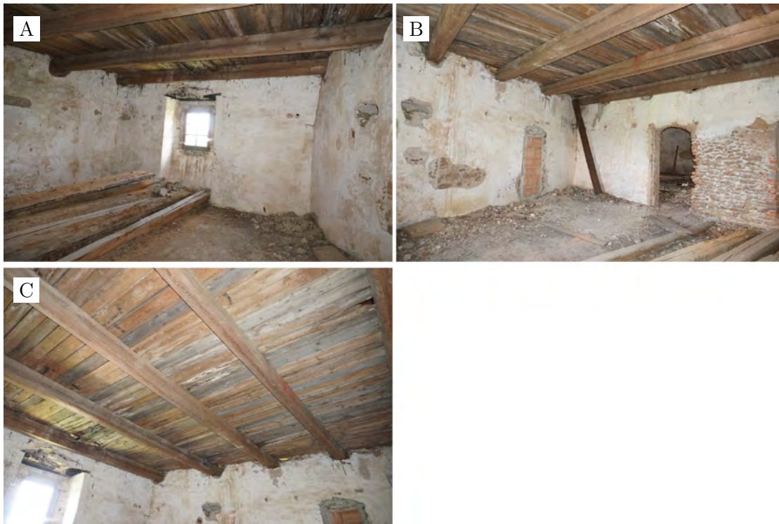
Abbildung A.50.: Ansichten des Westraums im Dachgeschoss: Westseite (A); Ostseite mit Mauerwerk aus Rundsteinen und Ziegeln, sowie zugemauerter Öffnung an der Nordostseite (B); Hölzerne Flachdecke (C).
