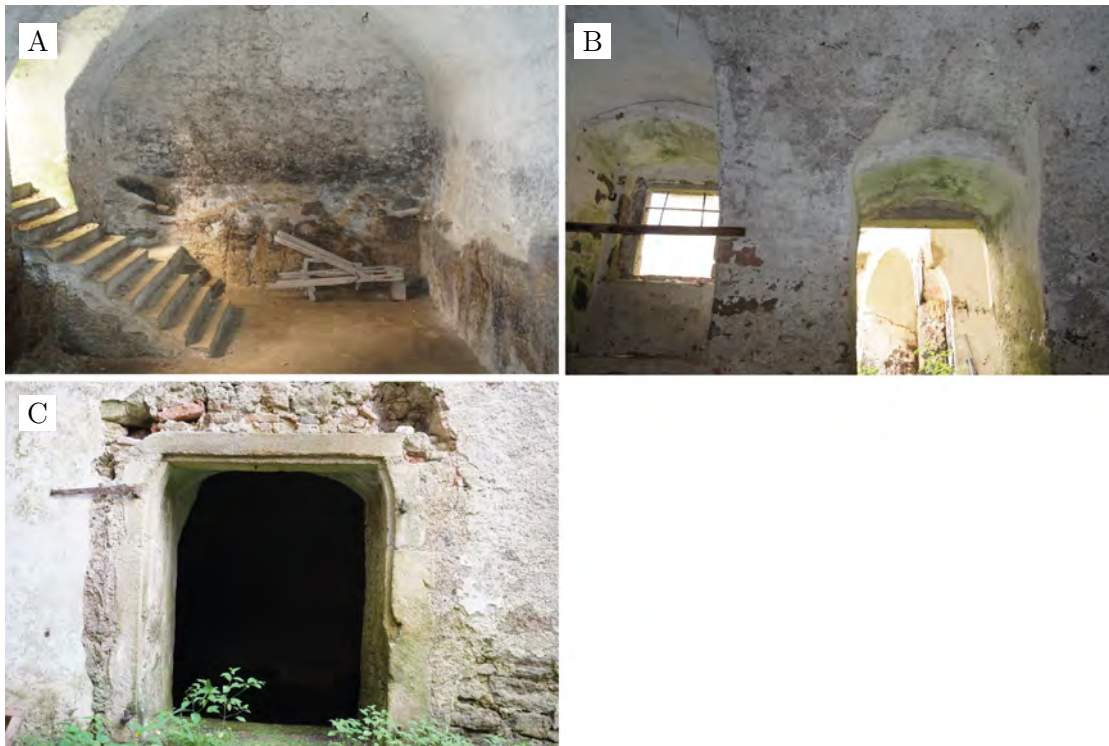
Abbildung A.6.: Ansichten des Kellerraums (Palasbau): Westseite (A); Südseite mit hofseitigem Fenster (B); Eingang vom Burghof (C).
