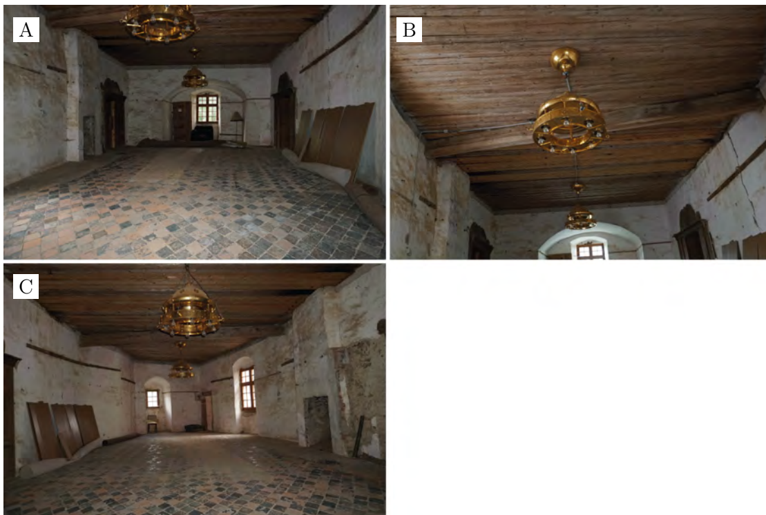
Abbildung A.43.: Engelstein: Ansichten des Gerichtssaals: Südseite mit Zugängen zu Westraum und Rittersaal (A); hölzerne Flachdecke mit Querbalken und Lustern (B); Nordseite mit Kamin rechtsseitig (C).
