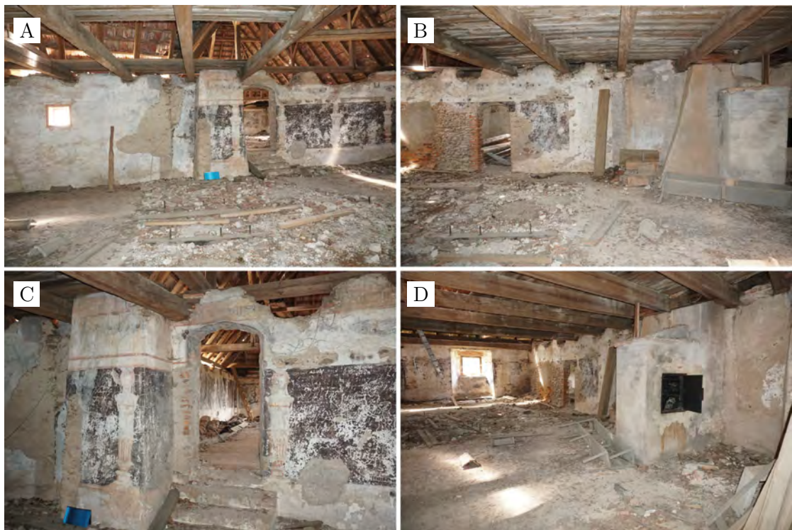
Abbildung A.47.: Ansichten des Freskensaal West: Ostseite (A); Westseite (B); Durchgang zum Freskensaal Ost (C); Ofen an der Westseite, Blick von Norden (D).
