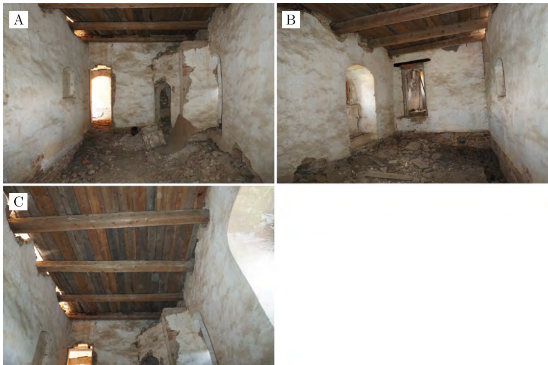
Abbildung A.45.: Ansichten der oberen Galerie: Nordseite mit Aufgang zum Freskensaal und Kamin rechtsseitig (A); Südseite mit Zugang zur Galerie (B); Hölzerne Flachdecke mit Querbalken (C).
