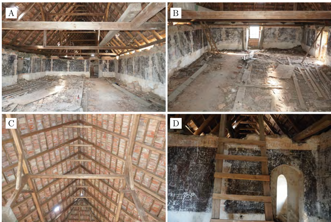
Abbildung A.48.: Ansichten des Freskensaals Ost: Westseite (A); Ostseite (B); Dachstuhl (C); Aufgang zum Bergfried Nordseite (D).
