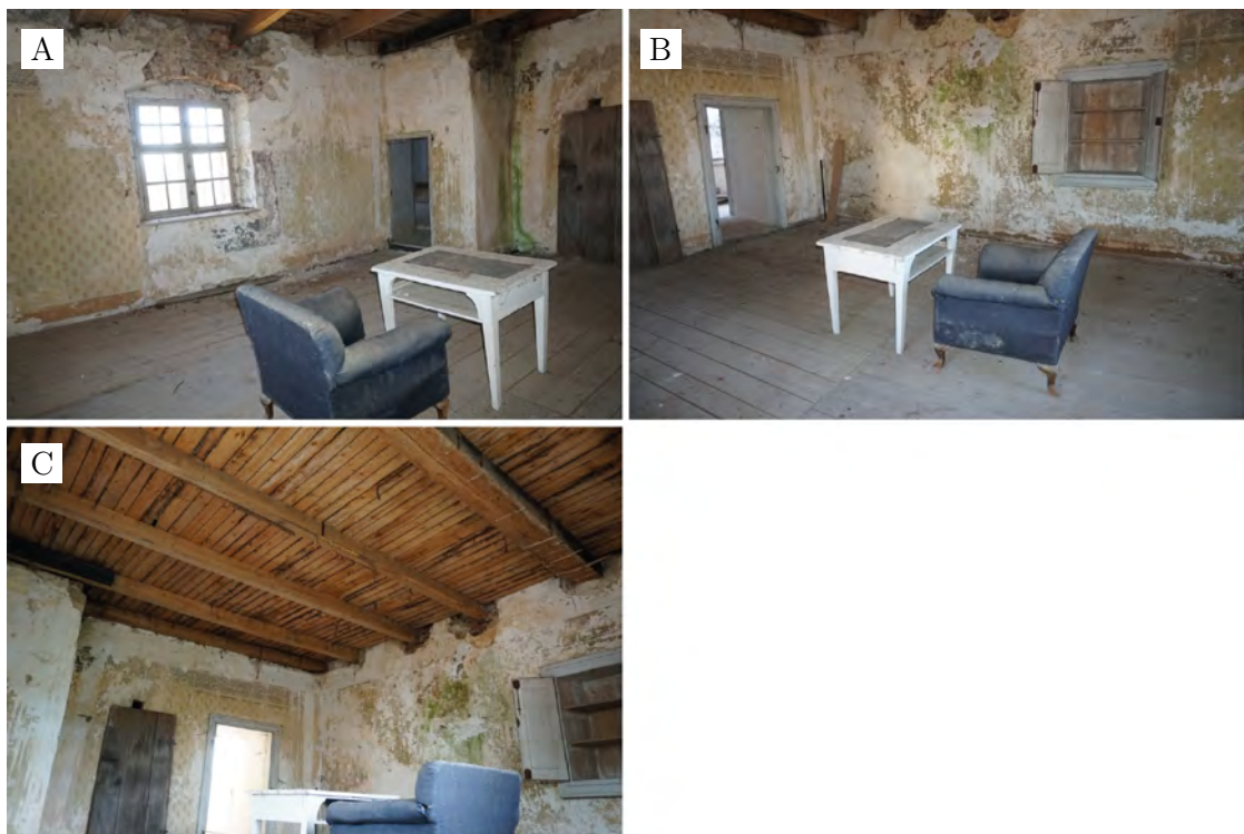
Abbildung A.38.: Ansichten des Torwarts, 2. OG: Südostseite (A); Südwestseite (B); Flachdecke (C).
