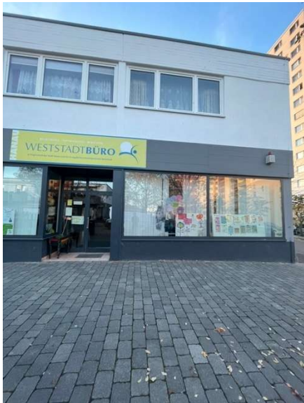
V10.A Außenansicht Weststadtbüro
