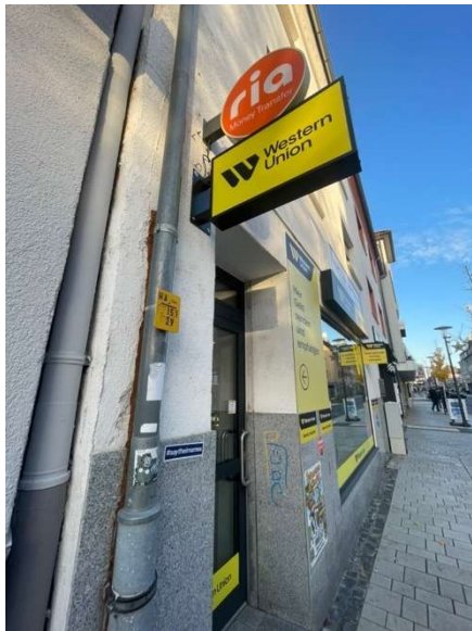
V08.A – Wasserrohr und Hauswand vor Kiosk
