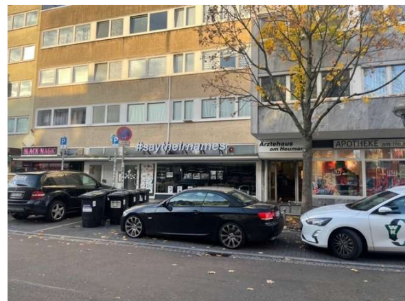
V03.B Ansicht von gegenüberliegender Straßenseite auf das Ladenlokal
