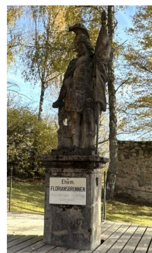
Abbildung 41: Sanierter Brunnen des Heiligen Florian (eigene Aufnahme).
