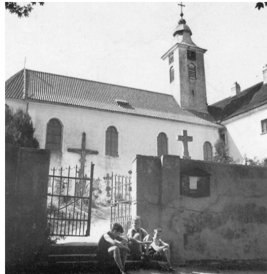
Abbildung 12: Friedhof und die an das Schloss angebaute Pfarrkirche von Groß-Poppen im Sommer 1938 (allentsteig.at).
