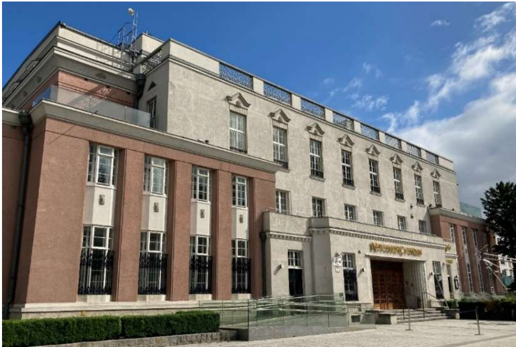
Abb. 36: Schmid/Aichinger, Österreichisches Verkehrsbüro , 1922-1923, Fassade mit Eingangsportal.
