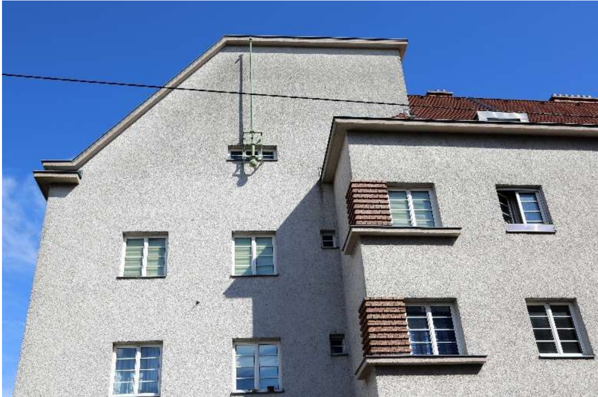
Abb. 118: Schmid/Aichinger, Somogyihof , 1927-1929, Ecktrakt Heinrich-Collin-Straße – Mossbachergasse.
