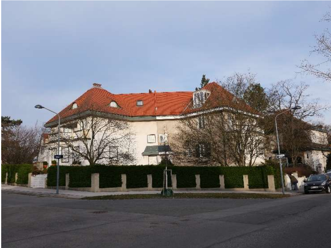
Abb. 20: Schmid/Aichinger, Gartenstadtsiedlung Ostmark , Haus am Rondeau, 1912-1913.
