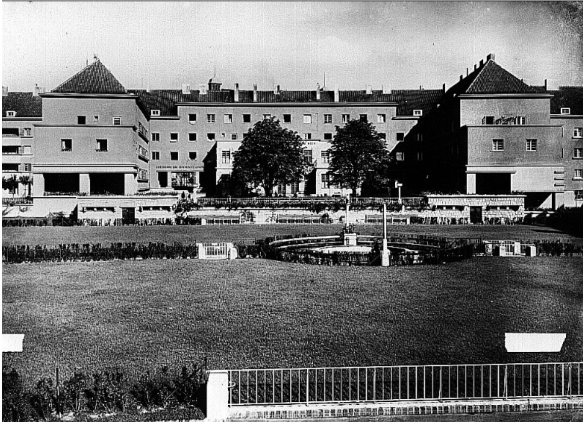
Abb. 124: Schmid/Aichinger, Somogyihof , 1927-1929, Gartenhof, Blick zu den Häusern an der Heinrich-Collin-Straße.
