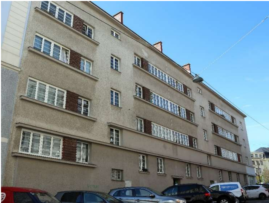
Abb. 116: Schmid/Aichinger, Somogyihof , 1927-1929, Fassade Mitisgasse.
