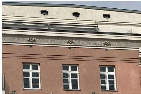
Abb. 41: Ornament am Kranzgesims.
