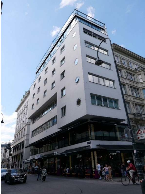
Abb. 131: Schmid/Aichinger, Zum Römertor , 1934-1935, Fassaden an der Rotenturmstraße und am Lichtensteg.
