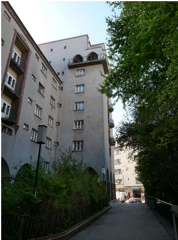
Abb. 71: Schmid/Aichinger, Rabenhof , 1926-1928, turmartiger Bau mit Flachdach.
