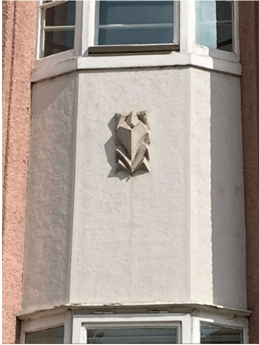
Abb. 40: Ornament zwischen Erdgeschoss und erstem Obergeschoss.
