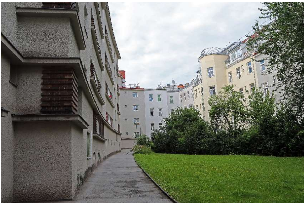
Abb. 125: Schmid/Aichinger, Somogyihof , 1927-1929, Gebädetrakt, der an die Häuser in der Mitisgasse anschließt.
