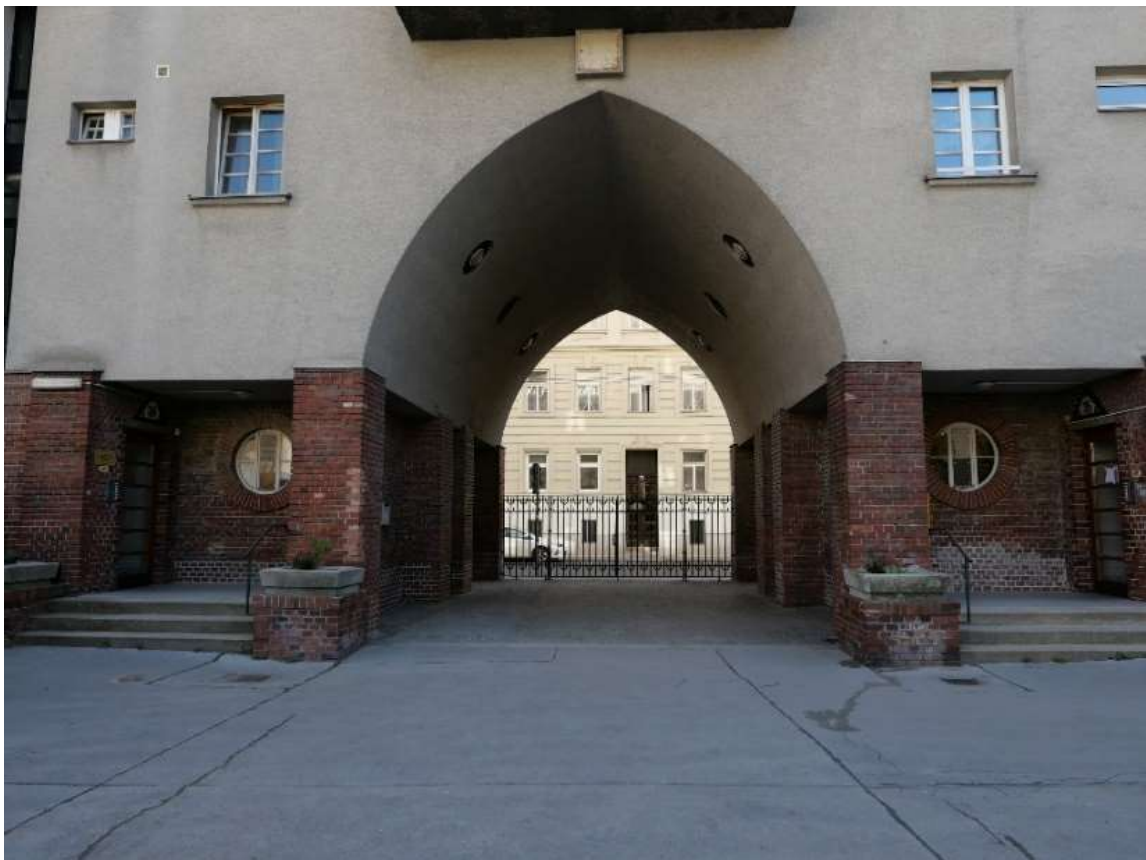
Abb.76: Schmid/Aichinger, Rabenhof , 1926-1928, Torbogen zur Baumgasse.
