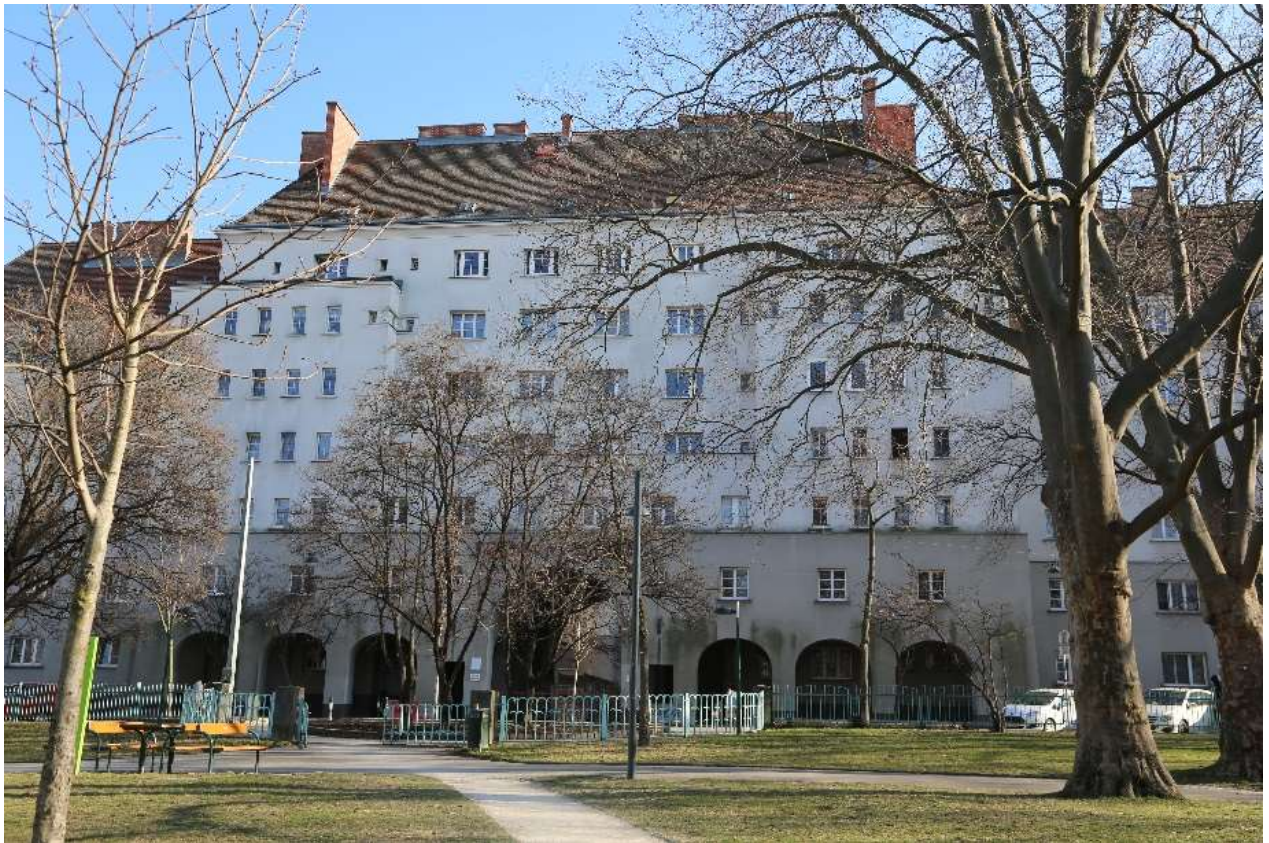
Abb. 47: Schmid/Aichinger, Fuchsenfeldhof , 1922-1923, Fassade an der Neuwallgasse.
