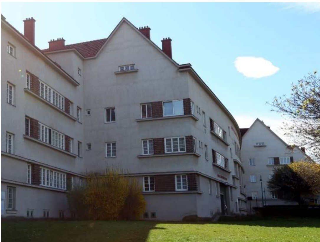
Abb. 117: Schmid/Aichinger, Somogyihof , 1927-1929, Gebäude an der Heinrich-Collinstraße.
