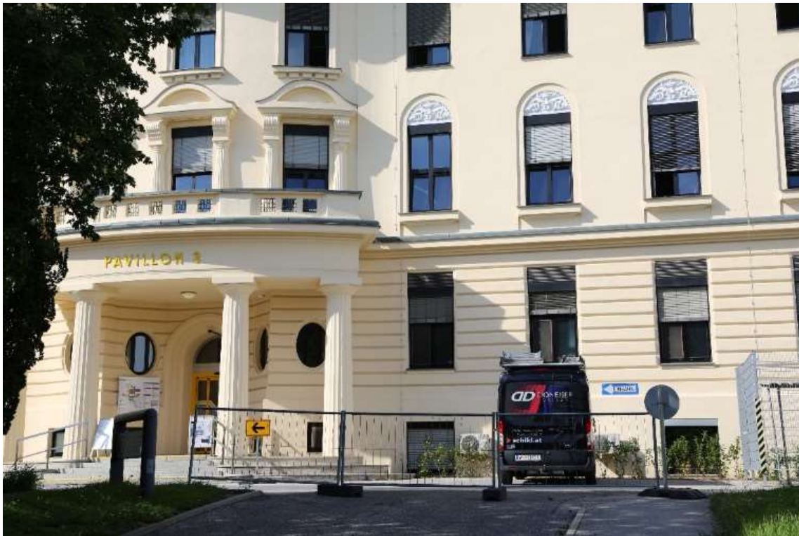
Abb. 27: Schmid/Aichinger, Erzherzog Rainer-Militärspital , 1914-1915, Eingangsportal.
