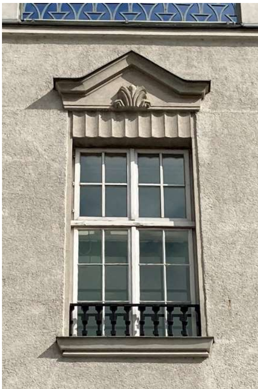
Abb. 39: Fenster im zweiten Obergeschoss.
