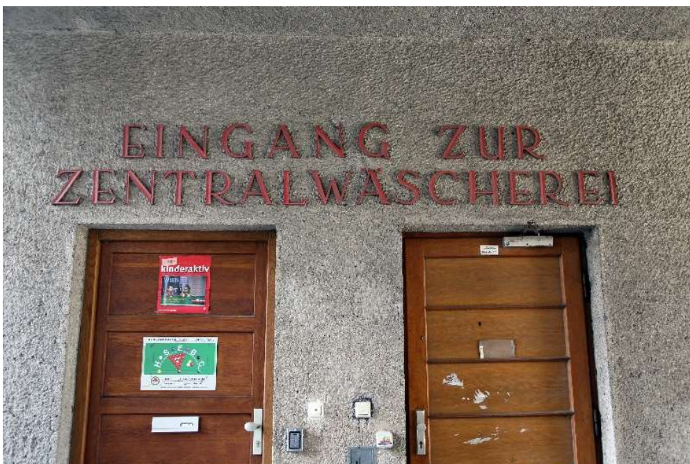
Abb. 104: Schmid/Aichinger, Somogyihof , 1927-1929, Eingang zur Zentralwäscherei.
