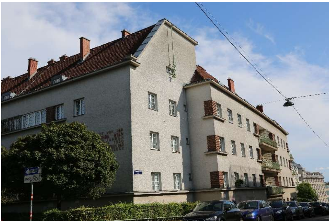
Abb. 113: Schmid/Aichinger, Somogyihof , 1927-1929, Ecktrakt Heinrich Collin-Straße – Gusenleithnergasse.
