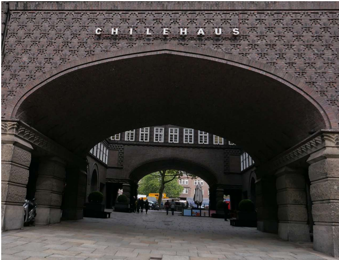
Abb. 151: Fritz Höger, Chilehaus , 1922-1924, Fassade mit Rautenrelief.
