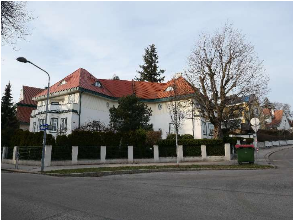
Abb. 21: Schmid/Aichinger, Gartenstadtsiedlung Ostmark , Haus am Rondeau, 1912-1913.
