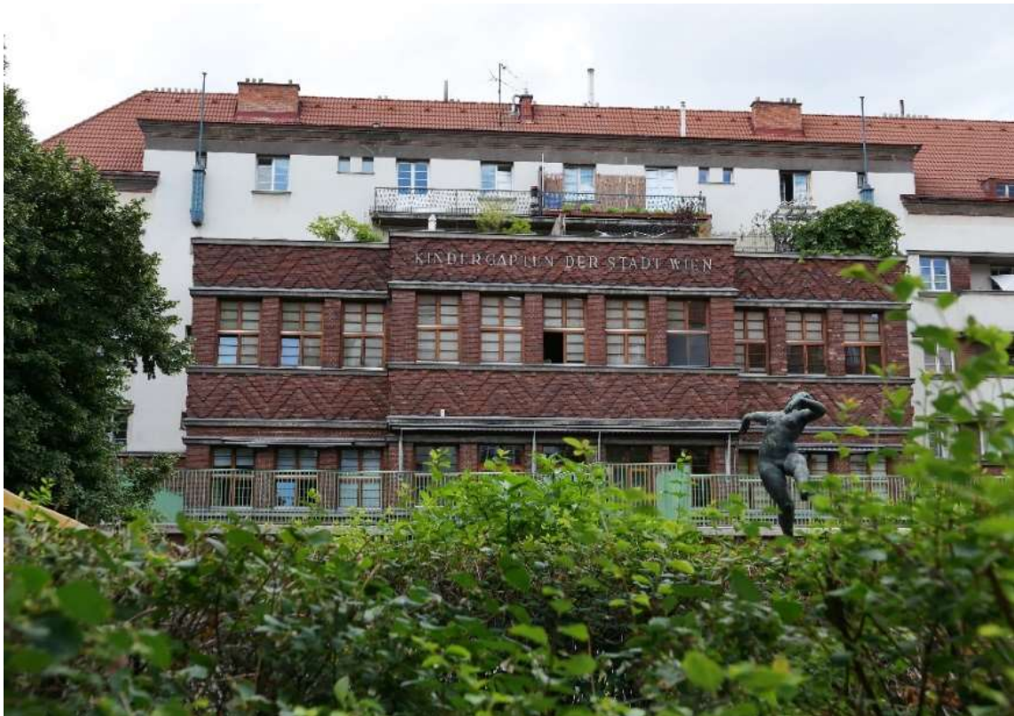
Abb. 90: Schmid/Aichinger, Rabenhof , 1926-1928, 2. Hof mit Kindergarten.
