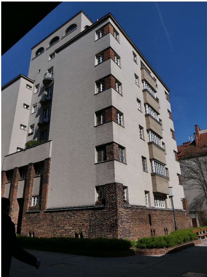
Abb. 74: Schmid/Aichinger, Rabenhof , 1926-1928, turmartiger Bau im 3. Hof.
