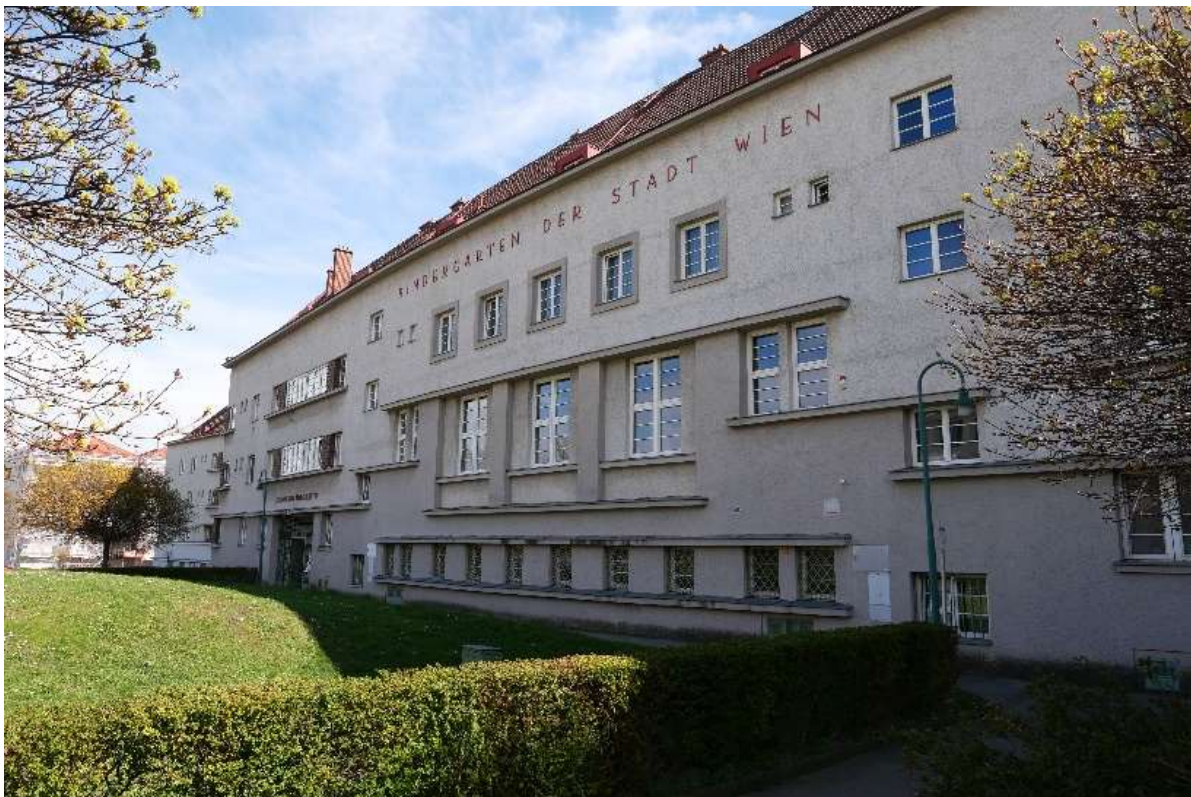
Abb. 119: Schmid/Aichinger, Somogyihof , 1927-1929, Straßenfassade des Kindergartens.
