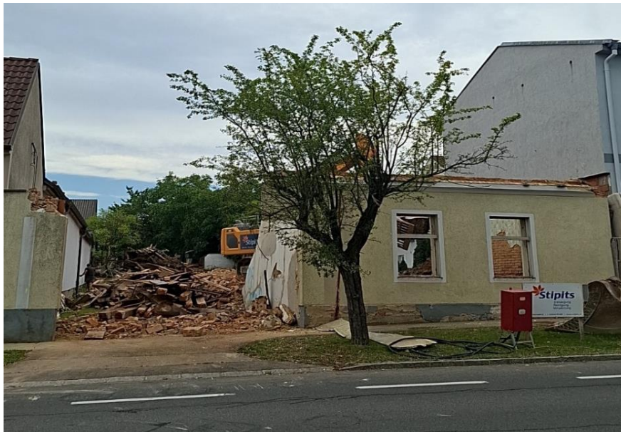
Abb. 13: Abriss eines langjährig leerstehenden Gebäudes im Ortskern als Vorbereitung für eine Neubebauung im Rahmen der Innenentwicklung in Markt St. Martin (eigene Aufnahme, 2025)
