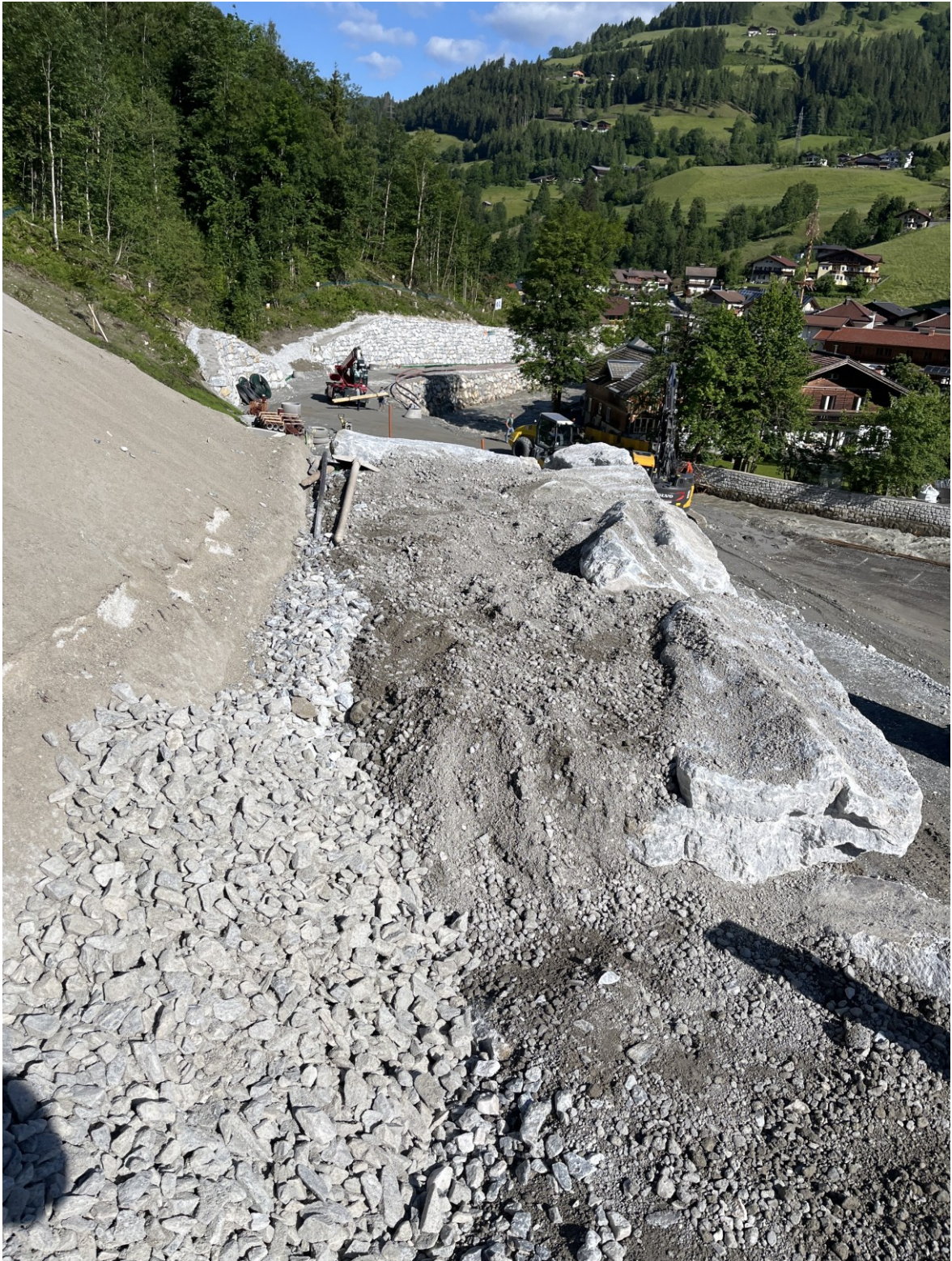
Abbildung 45: Erdbauarbeiten (Swietelsky, o.J.)
