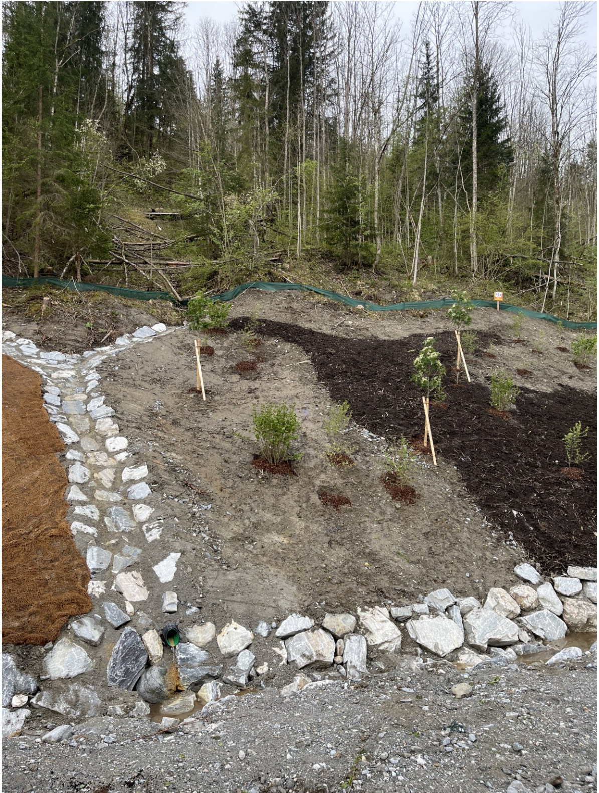
Abbildung 43: Begrünung und Entwässerung (Swietelsky, o.J.)
