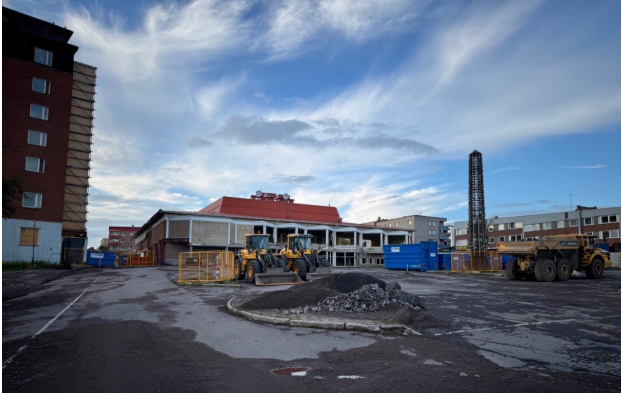
Abbildung 19: Abriss im alten Zentrum der Stadt (eigene Aufnahme: Vänortstorget Juli 2025).
